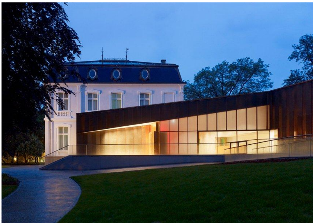
Εικ. 12. Νυχτερινή άποψη της βίλας και της σύγχρονης επέκτασης. Villa Vauban, Λουξεμβούργο. (Villa Vauban, χ.χ.).
