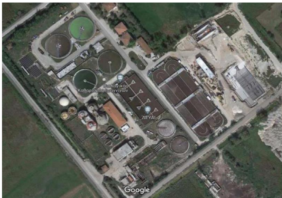
Εικόνα 15 : Εγκατάσταση Επεξεργασίας Λυμάτων Ιωαννίνων. Πηγή : (google maps 2023)
