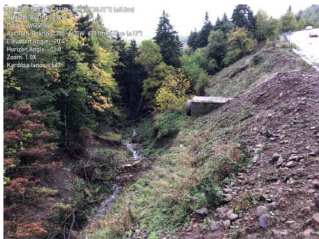
(γ) Διάταξη Ολισθαίνοντος Τεχνητού και Φυσικού Πρανούς (Φωτ. Α. Γεωργαλάς, 2021).
