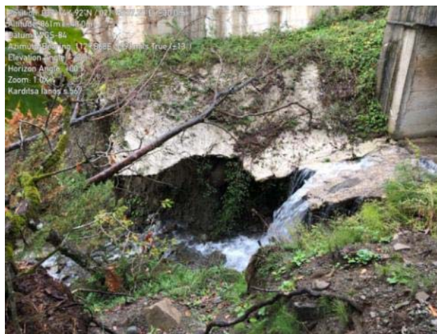
(β) Υποσκαφή και Δομική Αστοχία Υδραυλικών Έργων Οδού (Φωτ. Α. Γεωργαλάς, 2021).
