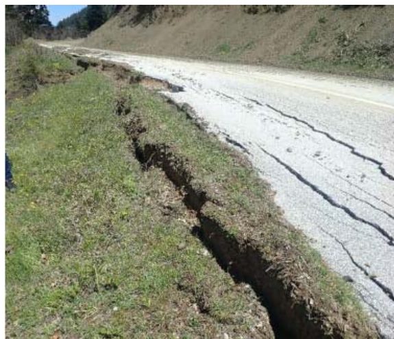
(β) Έντονες ρωγματώσεις και υποχώρηση οδοστρώματος (Φωτ. Α. Γεωργαλάς, 2021).
