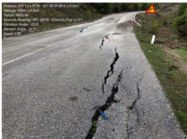
(α) Ανοικτές, παράλληλες, τοξοειδείς Ρωγμές στο Οδόστρωμα (Φωτ. Α. Γεωργαλάς, 2021).
