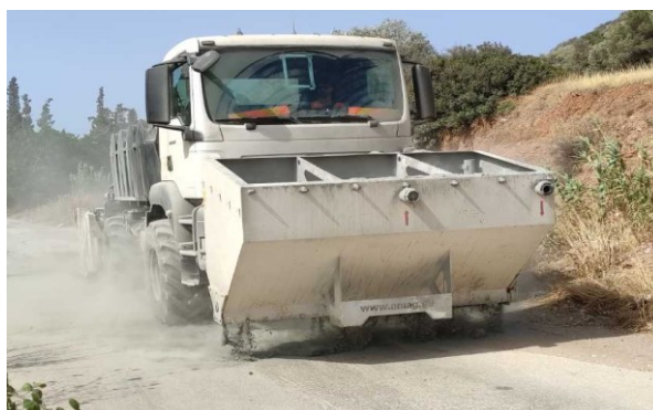
Εικόνα 32: Μηχάνημα αναμοχλευτή με την ειδική δεξαμενή τσιμέντου.
