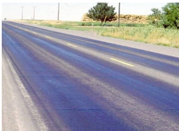
Εικόνα 14: Ανάδυση ασφάλτου σε περιοχή του εξωτερικού.
