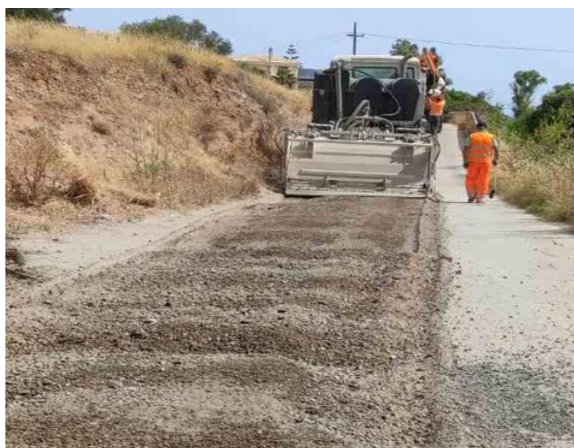
Εικόνα 33: Στιγμιότυπο διαδικασίας. (Νέα βάση οδού).
