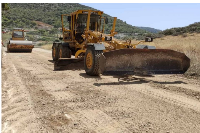
Εικόνα 34: Διαμόρφωση νέα βάσης οδού.
