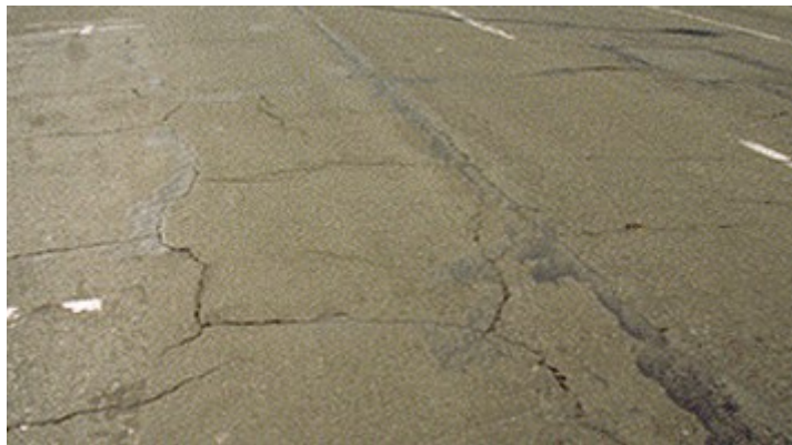
Εικόνα 9: Ρωγή συρρίκνωσης.
