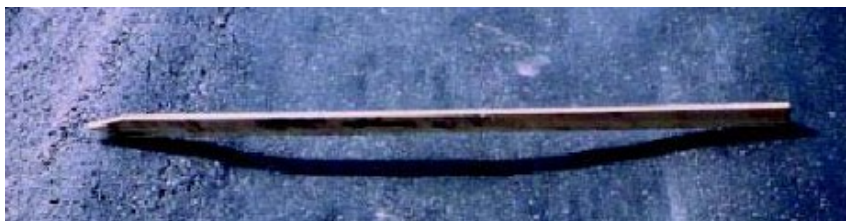
Εικόνα 11: Τροχοαυλάκωση.
