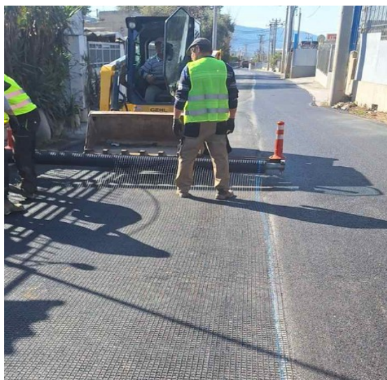
Εικόνα 27: Εφαρμογή ασφαλτοπλέγματος.
