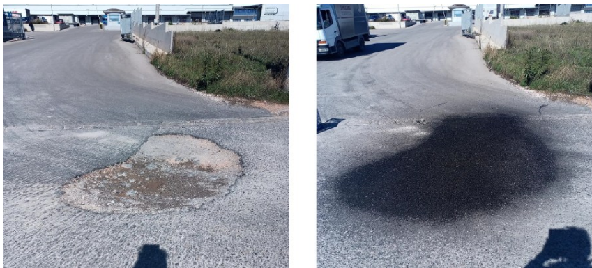
Εικόνα 41: Αποκατάσταση λακκούβας στον Ασπρόπυργο (πριν και μετά).
