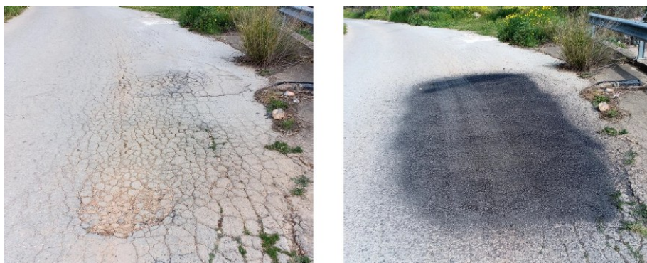
Εικόνα 42: Αποκατάσταση αλγατορικής ρωγμής (Πριν και μετά).
