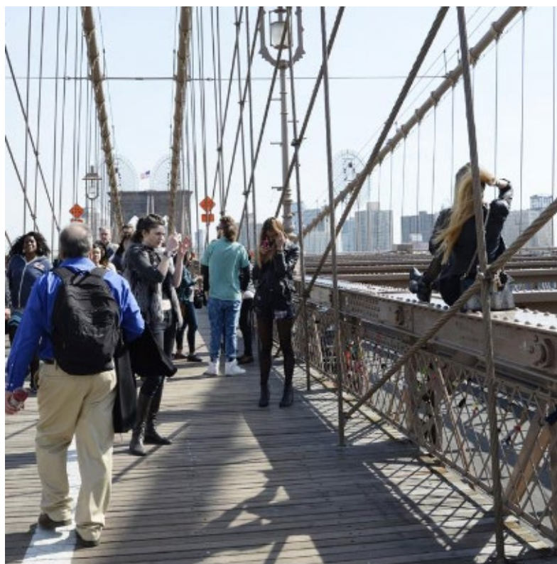
Εικόνα 2-1: Πεζόδρομος της Γέφυρας του Μπούκλιν (Brooklyn Bridge Promenade) (New York City [NYC] Department of Transportation, 2017).
