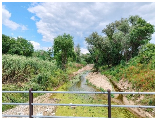
Εικόνα 81. Άποψη του ρέματος Καλλιφύτου στην περιοχή Ανάπλασης (τέλος Μαΐου 2026). Πηγή: Προσωπικό αρχείο Ε. Δελημπαλά
