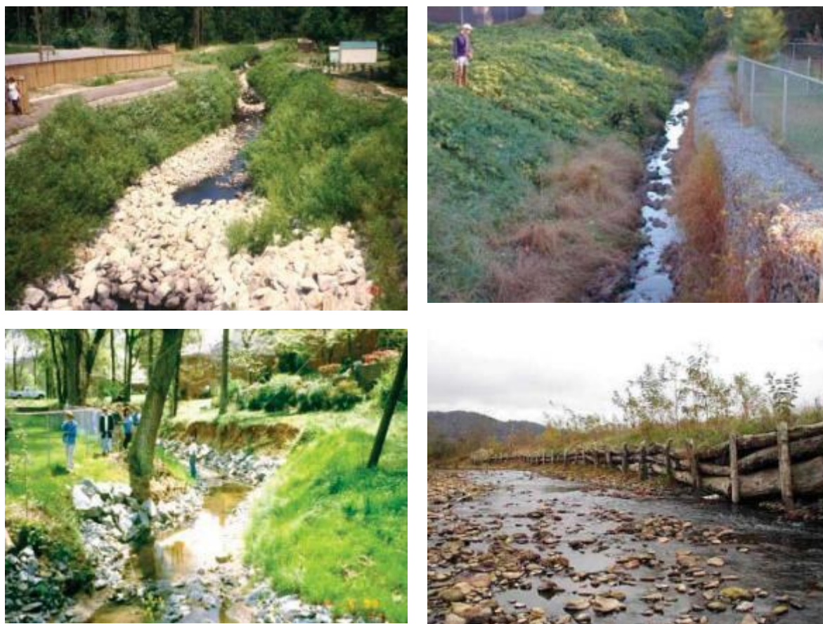
Εικόνα 114. Διάφοροι τρόποι σταθεροποίησης ρεμάτων. Πάνω και κάτω αριστερά: με riprap από μεγάλους ακανόνιστου σχήματος βράχους. Πάνω δεξιά: με gabion baskets, κλουβιά από συρματόπλεγμα γεμάτο πέτρες. Κάτω δεξιά: με κορμούς δέντρων. Πηγή: Stream restoration: A natural channel design handbook. Doll et al, 2003.
