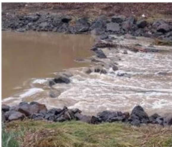
Εικόνα 25. Επιβράδυνση της ορμής του νερού με βράχους στο Jan Juc Creek. Πηγή: www.clearwatervic.com.au
