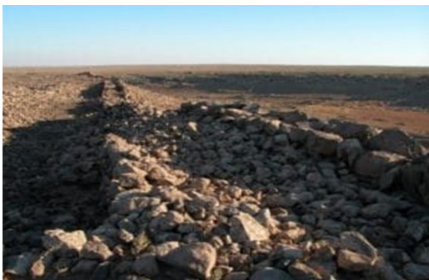
Εικόνα 1. Το Φράγμα της πόλης Τζάουα. Πηγή: https://tataandhoward.com
