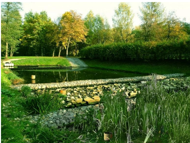
Εικόνα 8. Σύστημα διαδοχικής καθίζησης όμβριων υδάτων. Πηγή: climate-adapt.eea.europa.eu
