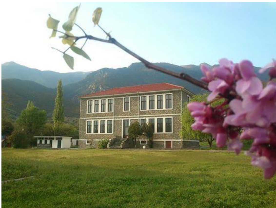
Εικόνα 20: Το Δημοτικό Σχολείο της Μουσθένης ανακαινισμένο το 2010 και ο αύλειος χώρος του. Φωτογραφία Γεωργία Σ.
