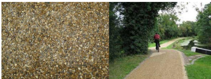
30-Εικόνα 5.4 Ασφαλός με φυτική συνδετική ουσία, Cycle Path Surface Options (2012)
