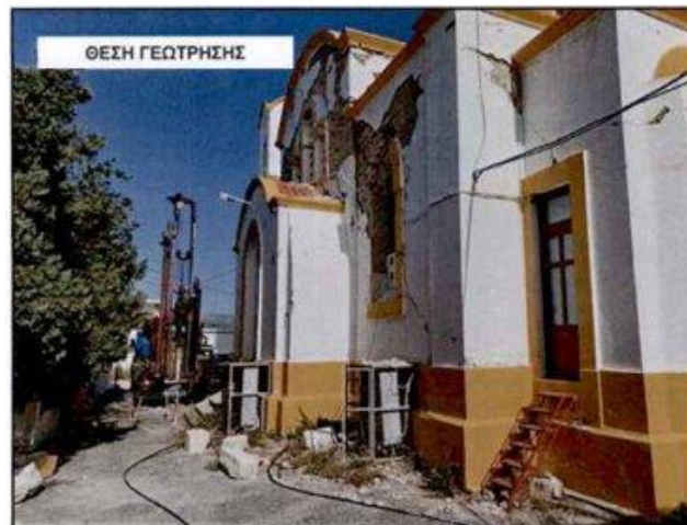
Εικόνα 4.19. Θέση γεώτρησης Γ3.
