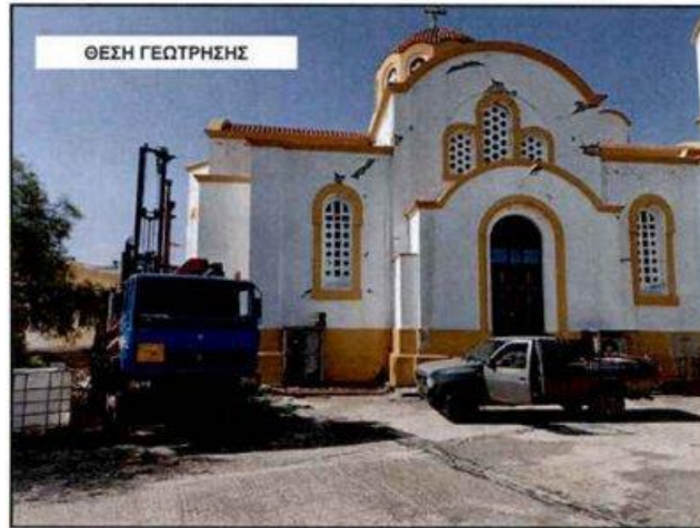
Εικόνα 4.15. Θέση γεώτρησης Γ1.
