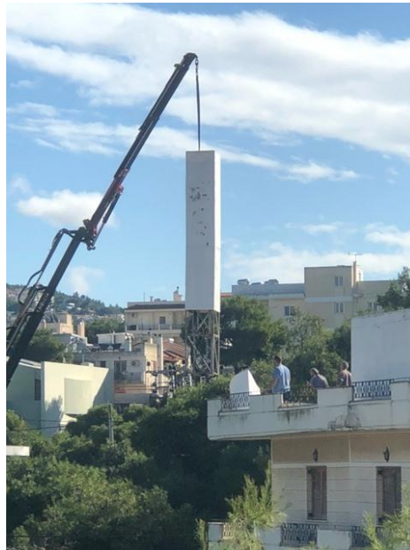
Εικόνα 8: Κεραία κινητής τηλεφωνίας κρυμμένη σε καμινάδα στην Νέα Ερυθραία. (Gazzetta, 2021)
