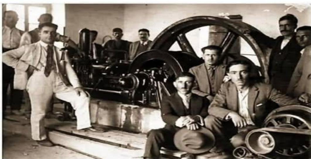
Εικ. 39. Εσωτερικό θερμικού εργοστασίου. Αριστερά διακρίνεται ο μηχανικός Γ. Η. Παπάζογλου. Έκτος από αριστερά διακρίνεται ο επιχειρηματίας Κ. Νάσιουτζικ (αρχείο Γ. Παπάζογλου).
