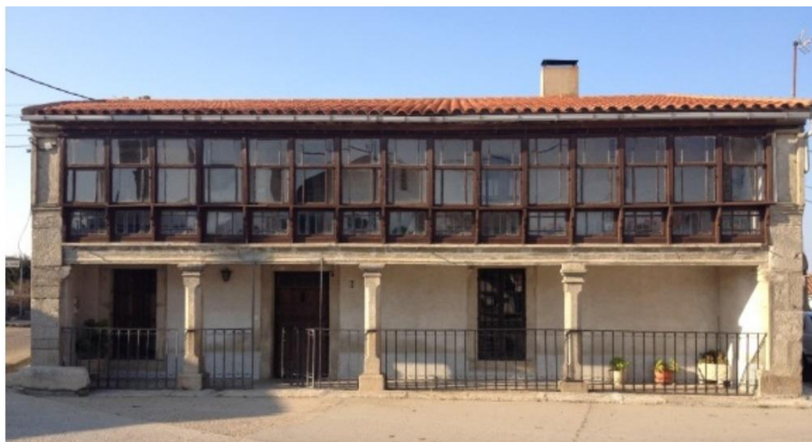
Εικόνα 42, Ηλιακός με ξύλινο πλαίσιο, Ganame, Ισπανία.
