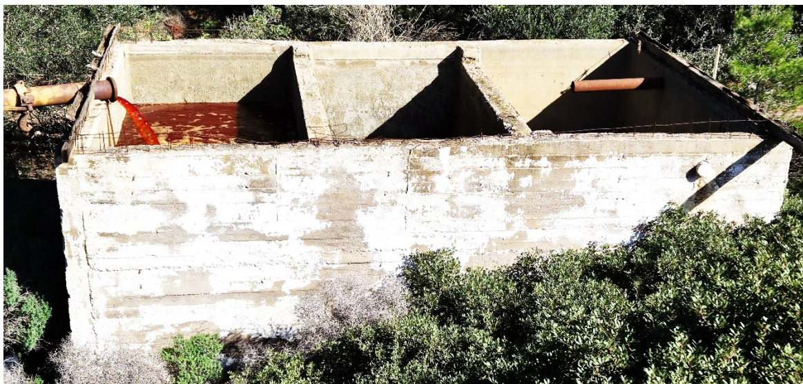
Σχήμα 34. Τυπική τσιμεντένια δεξαμενή καθίζησης υγρών αποβλήτων (ΕΑΣ-ΑΒΕΕ-ΣΕΛ,, 2019)
