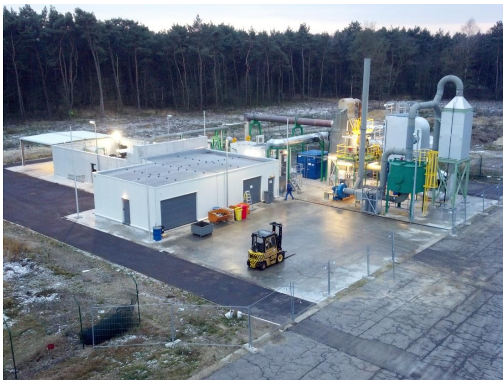
Σχήμα 22. Αποτεφρωτήρας Αποβλήτων Εκρηκτικών (Munitions Safety Information Analysis Center (MSIAC), 2006)
