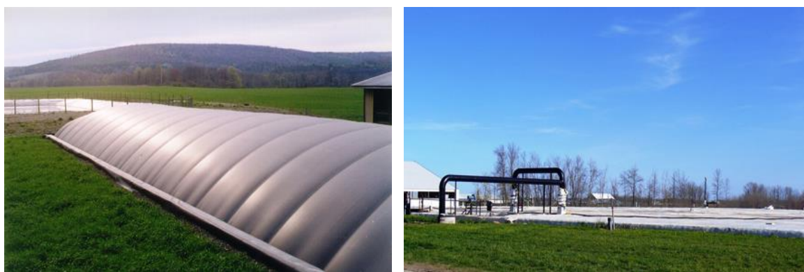
Εικόνα 6: Φωτογραφίες αναερόβιων χωνευτών ροής βύσματος με εύκαμπτο και σκληρό σκέπασμα. (US EPA, 2023)
