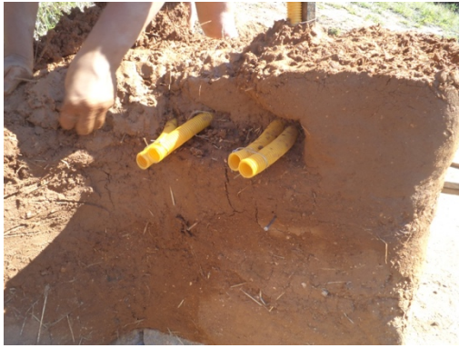
Εικόνα 5-6 : Τοποθέτηση ηλεκτρολογικών σωληνώσεων κατά την κατασκευή (Πηγή: https://moreecological.wordpress.com )
