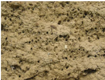
Εικόνα 5-18: Ανάπτυξη εντόμων σε τοίχο από ακατέργαστο πηλό
