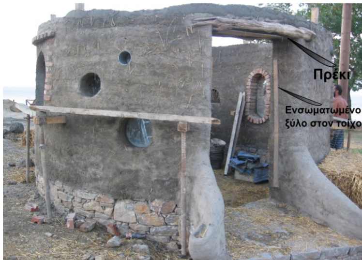
Εικόνα 5-5 : Κατασκευή ανοιγμάτων σε κτίσμα Cob ακατέργαστου πηλού (Πηγή: https://www.cob.gr ).
