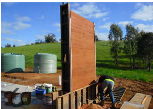
Εικόνα 4-10 : Δόμηση με τη μέθοδο συμπιεσμένης γης (Πηγή: Birznieks, 2013)
