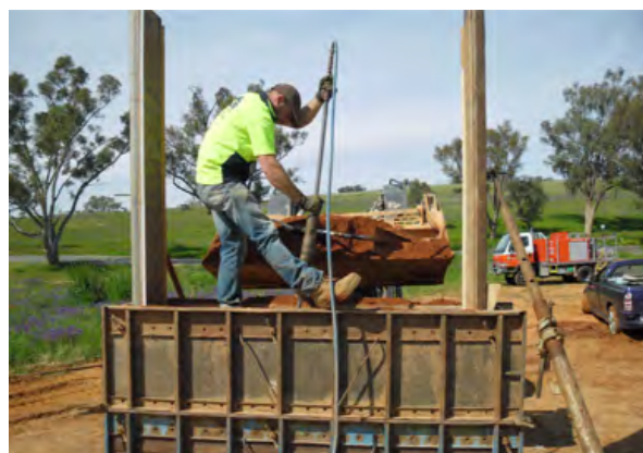
Εικόνα 4-10 : Δόμηση με τη μέθοδο συμπιεσμένης γης (Πηγή: Birznieks, 2013)
