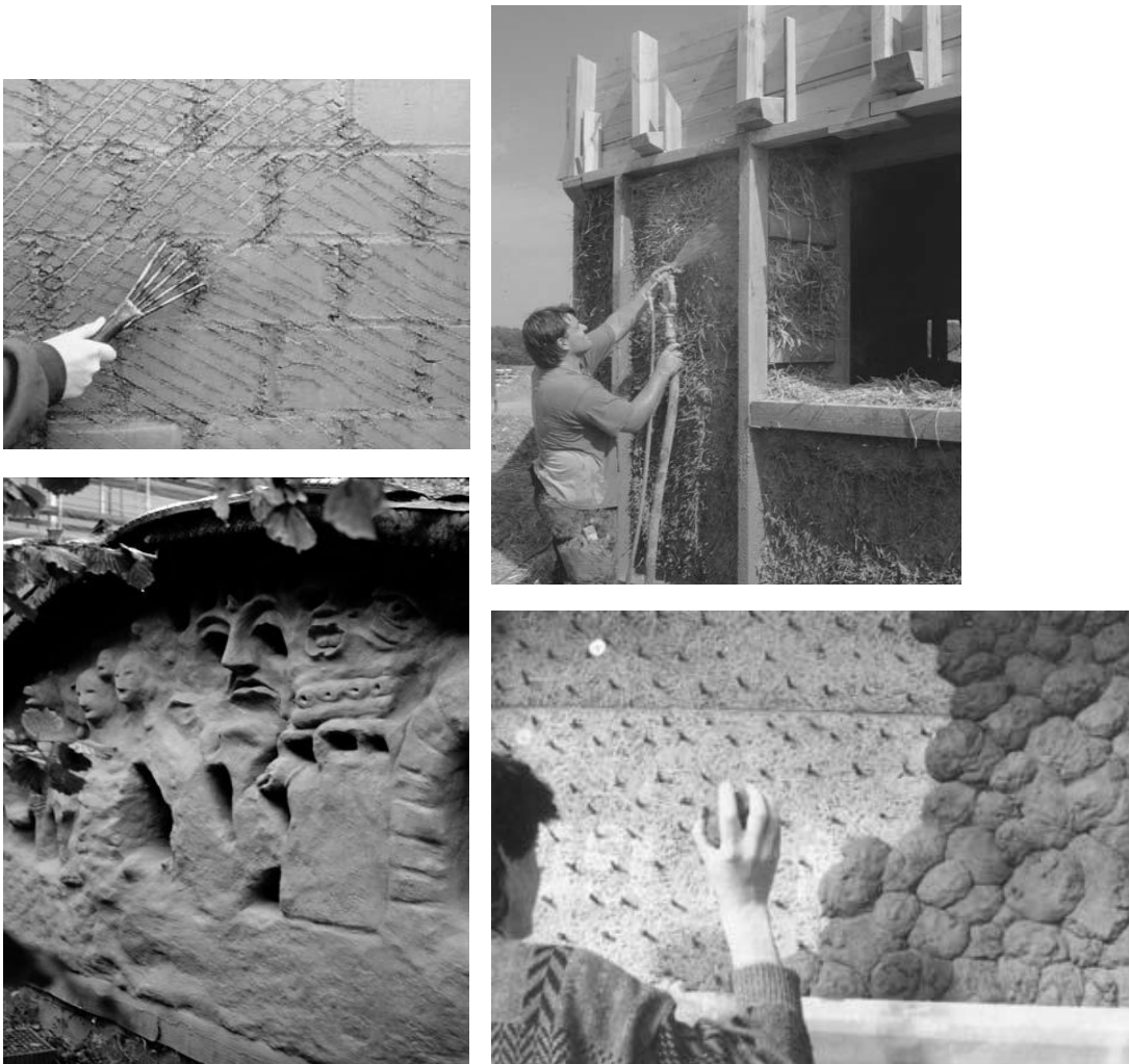
Εικόνα 5-10 : Επίχρισμα από πηλό (Πηγή: Minke, 2006).
