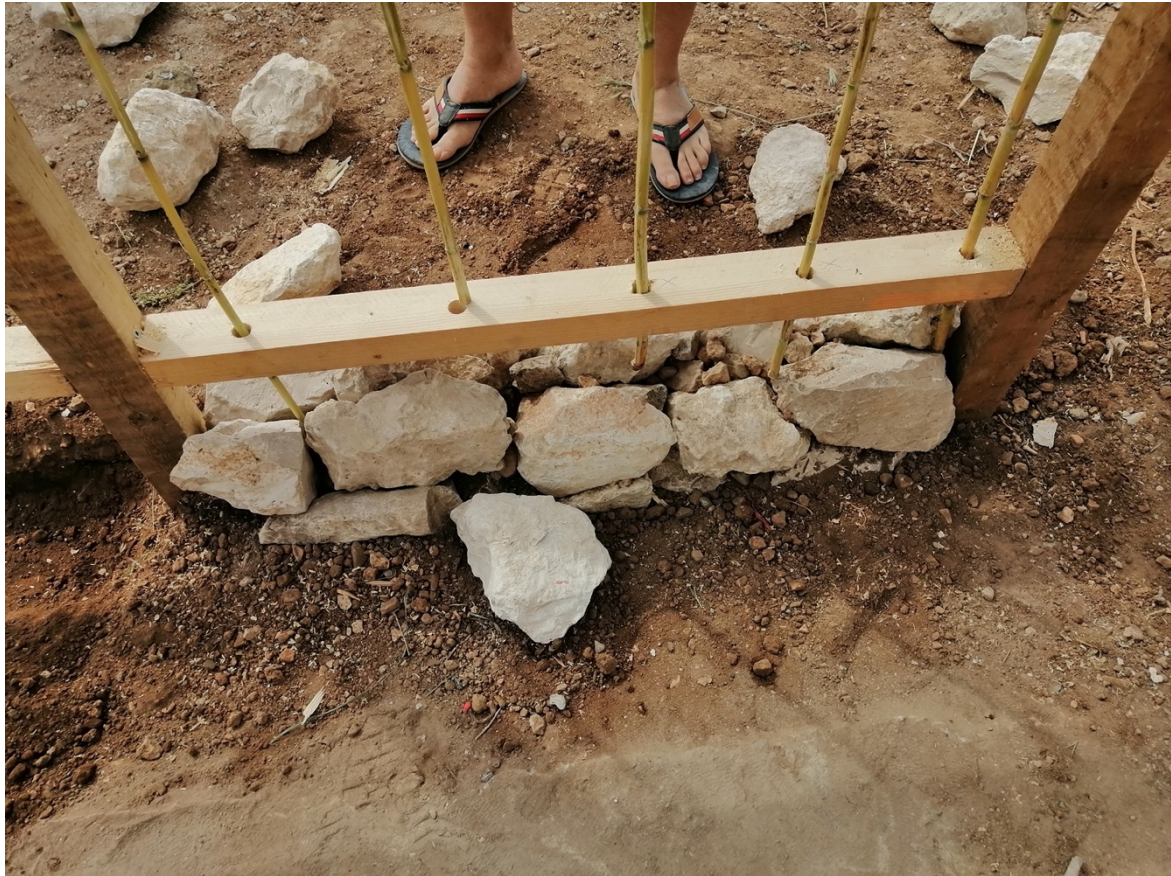
Εικόνα 5-17 : Κατακόρυφος οπλισμός με καλάμια και θεμελίωση με πέτρες σε τοιχοποιία με την τεχνοτροπία του τσατμά (Πηγή: Προσωπικό αρχείο 2022)
