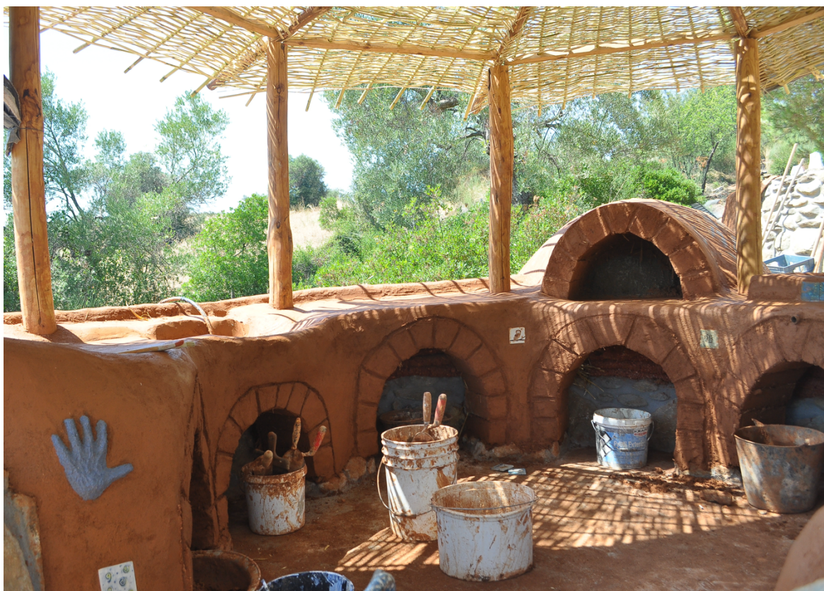
Εικόνα 5-1 : Κατασκευή ξυλόφουρνου και εξωτερικής κουζίνας με τη μέθοδο του στοιβαχτού πηλού. (Πηγή: Προσωπικό αρχείο, 2011)
