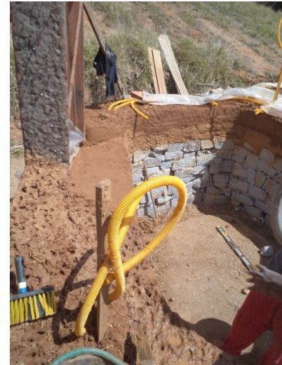
Εικόνα 5-6 : Τοποθέτηση ηλεκτρολογικών σωληνώσεων κατά την κατασκευή (Πηγή: https://moreecological.wordpress.com )
