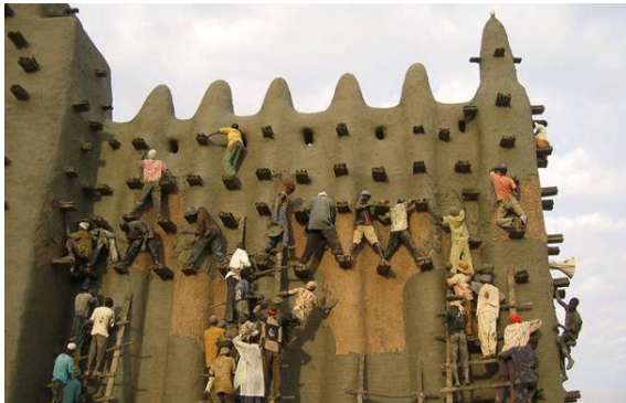
Εικόνα 5-20 : The Great Mosque, στο Djenné, Μαλί Επισκευή εξωτερικών τοίχων από ωμόπλινθους με μείγμα λάσπης, φλοιού ρυζιού και άχυρο (Πηγή: Πιτυτζόγια, 2014 & http://www.naturalhomes.org/great-mosque-djenne.htm )
