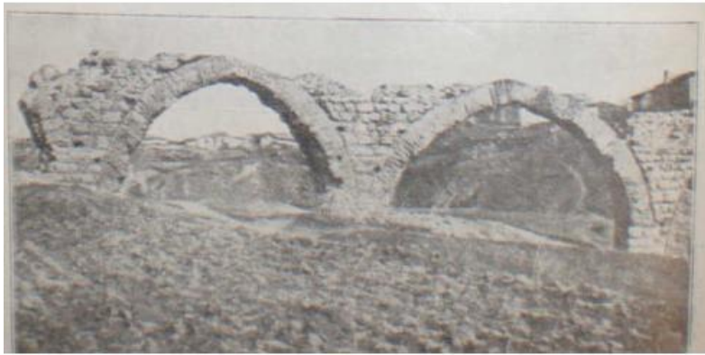
Εικόνα 5: Το υδραγωγείο δυτικά της μονής. πηγή: Τεντώνης, 2014
