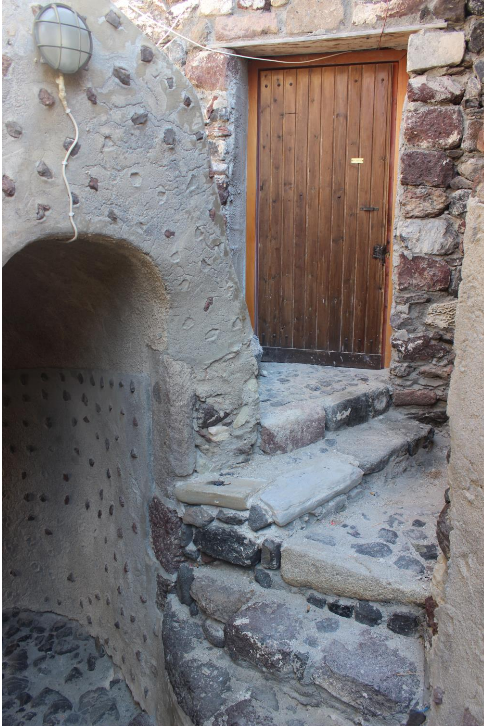
Εικόνα 67 Φωτογραφία τοίχου επιχρισμένου με σοβά και μικρά κομμάτια κοκκινόπετρας, πηγή: προσωπικό αρχείο
