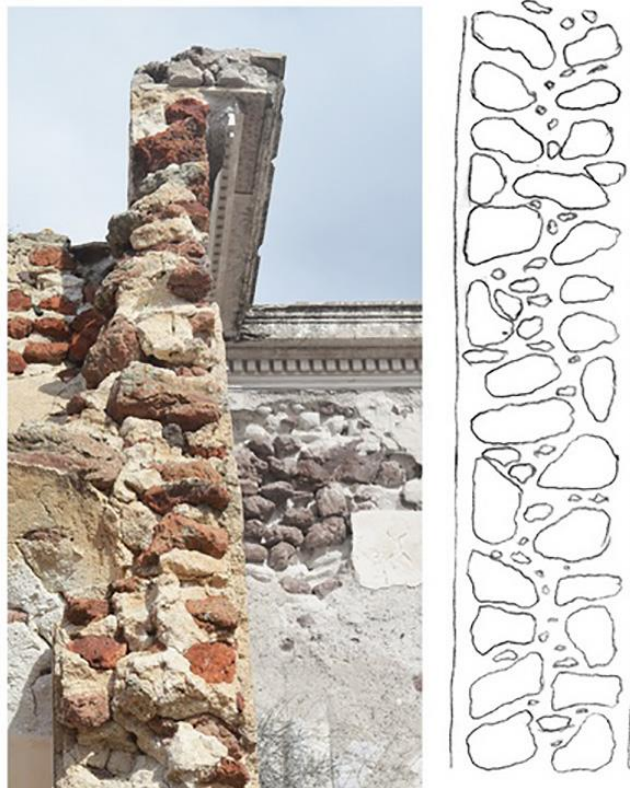
Εικόνα 58 Φωτογραφία και σκίτσο απλής τοιχοποιίας κατοικίας στη Σαντορίνη, πηγή: Οία, προπτυχιακή εργασία Ε.Μ.Π., 2016
