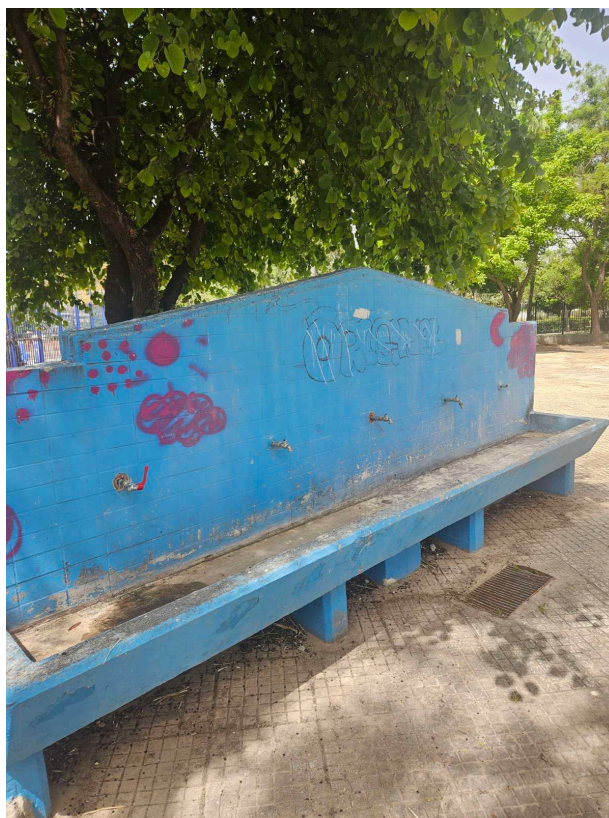
Εικόνα 27. Φθορές σε υπαίθριες βρύσες
