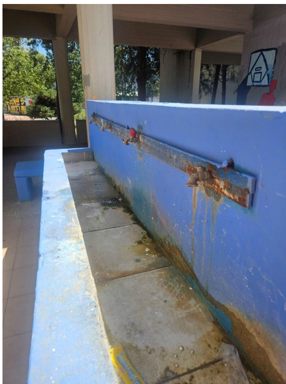
Εικόνα 11. Φθορές σε υπαίθριες βρύσες
