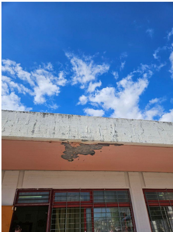
Εικόνα 18. Φθορές σε οροφή
