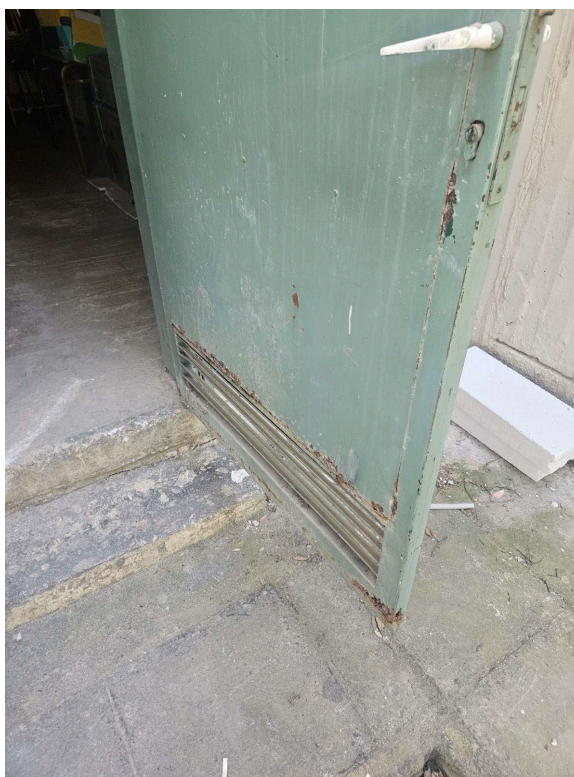
Εικόνα 12. Φθορές κουφωμάτων
