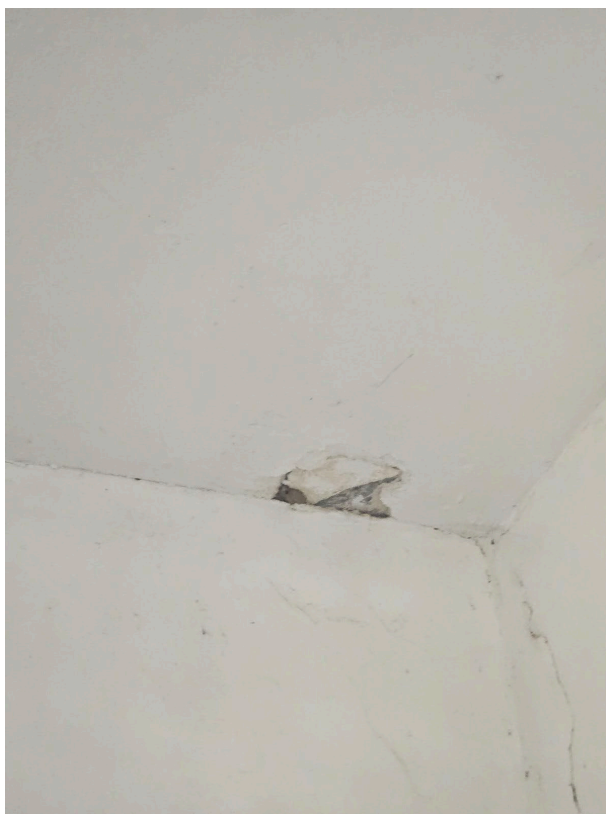
Εικόνα 7. Εμφάνιση υγρασίας
