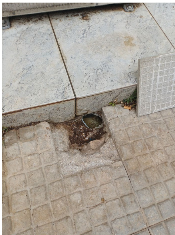
Εικόνα 37. Φραγμένη υδρορροή
