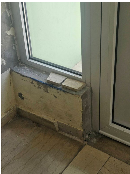
Εικόνα 1. Φθαρμένο κλιμακοστάσιο, αποκόλληση υλικών
