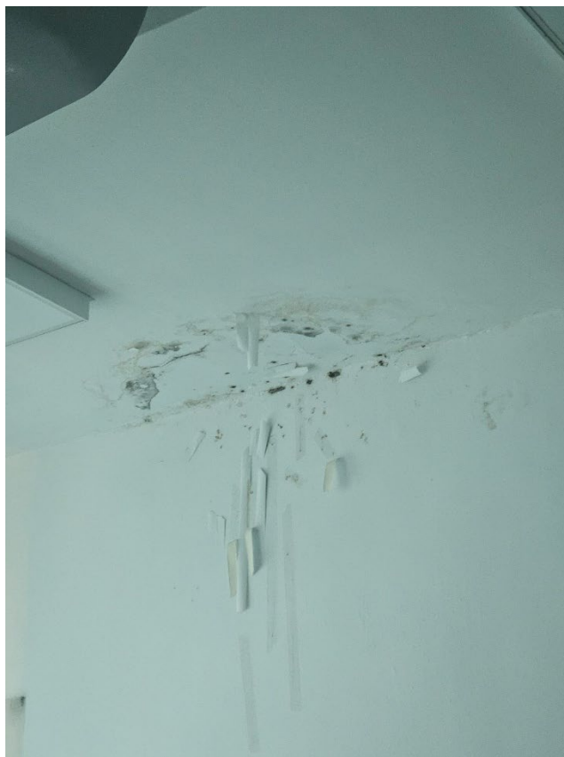
Εικόνα 4. Εμφάνιση υγρασίας
