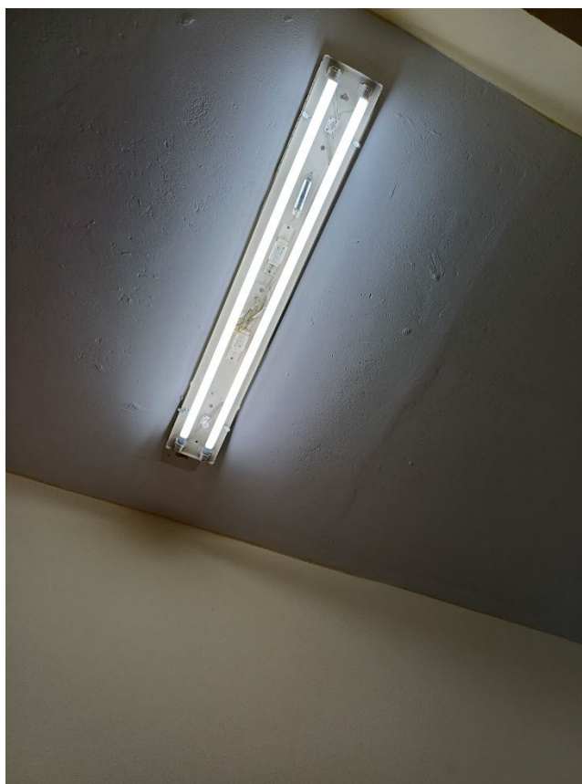
Εικόνα 29. Εκτεθειμένος λαμπτήρας
