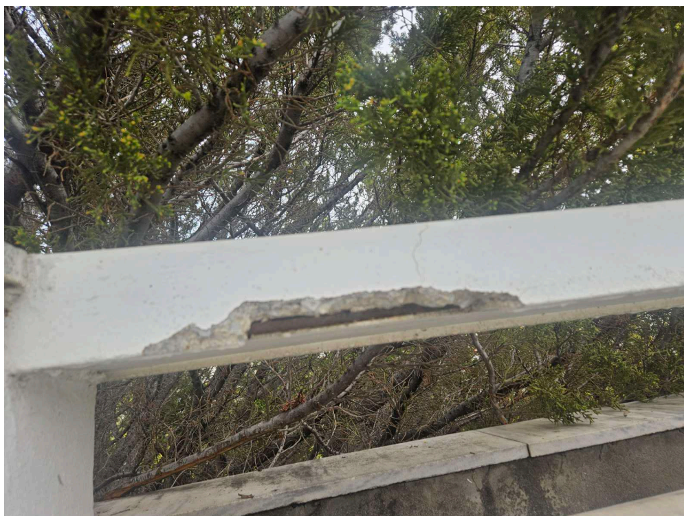
Εικόνα 24. Φθορά δοκού
