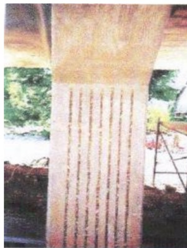
Σχήμα 8.1: Εφαρμογή FRP με την χρήση ράβδων ΙΟΠ (Πηγή: «ΕΝΙΣΧΥΣΗ ΣΤΟΙΧΕΙΩΝ ΟΠΛΙΣΜΕΝΟΥ ΣΚΥΡΟΔΕΜΑΤΟΣ ΜΕ ΦΥΛΛΑ ΚΑΙ ΡΑΒΔΟΥΣ (NSM) ΑΠΟ ΙΝΟΠΛΙΣΜΕΝΑ ΠΟΛΥΜΕΡΗ» ΑΣΗΜΑΚΟΠΟΥΛΟΣ ΣΠΥΡΙΔΩΝ, ΦΟΥΝΤΟΠΟΥΛΟΣ ΚΩΝΣΤΑΝΤΙΝΟΣ)
