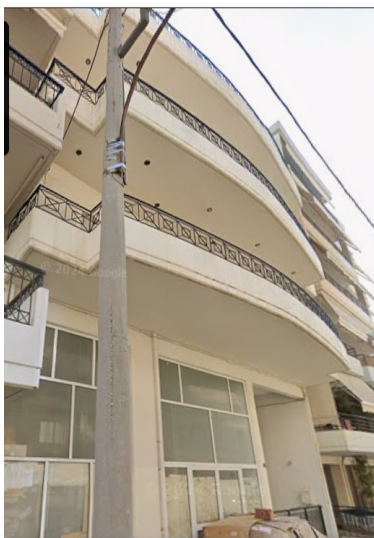
Σχήμα 4.13: Φωτογραφία του υπό μελέτη κτιρίου
