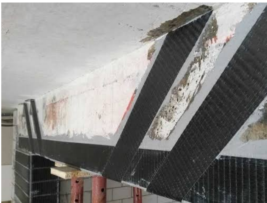
Σχήμα 8.2: Εφαρμογή φύλλων ινοπλισμένων πολυμερών με τη χρήση κόλλας
