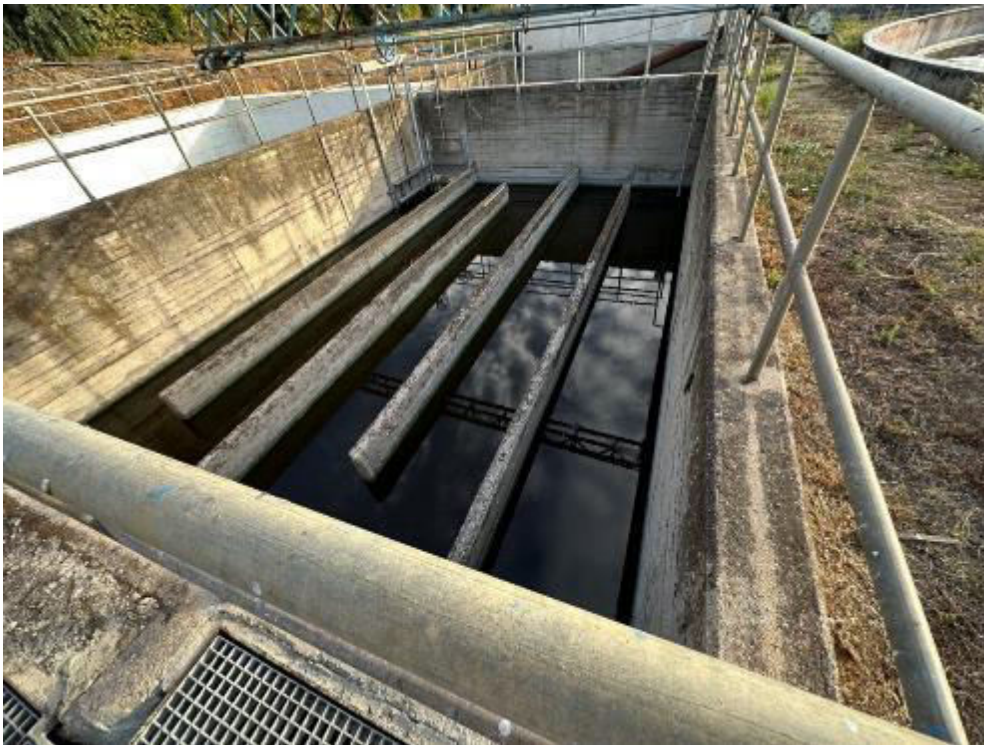
Εικόνα 4.6. Μαϊάνδρος - κανάλι χλωρίωσης ΜΚΑ ΒΠΠΕ Πατρών.
