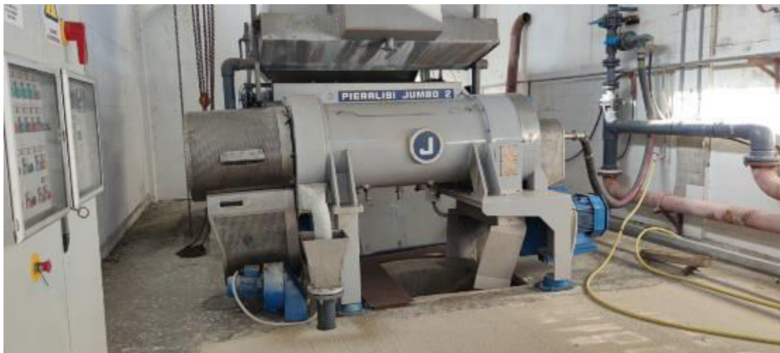
Εικόνα 4.8. Φυγοκεντρικός διαχωριστής (αφυδάτωση ιλύος) ΜΚΑ ΒΠΠΕ Πατρών.
