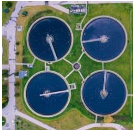
Εικόνα 3.1 Δεξαμενές πρωτοβάθμια καθίζησης.
