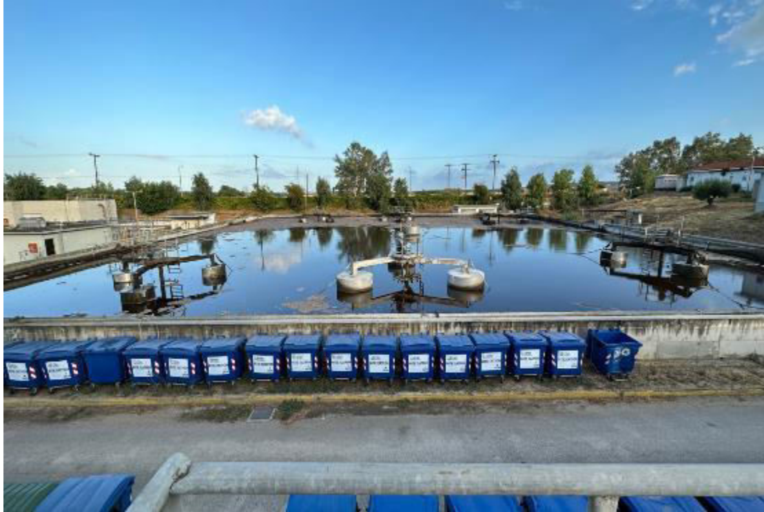
Εικόνα 4.3. Δεξαμενή αερισμού ΜΚΑ ΒΠΠΕ Πατρών.
