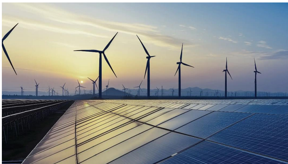
Εικόνα 1.1 Υβριδικό πάρκο παραγωγής ενέργειας με συνδυασμό φωτοβολταϊκών και ανεμογεννητριών.
