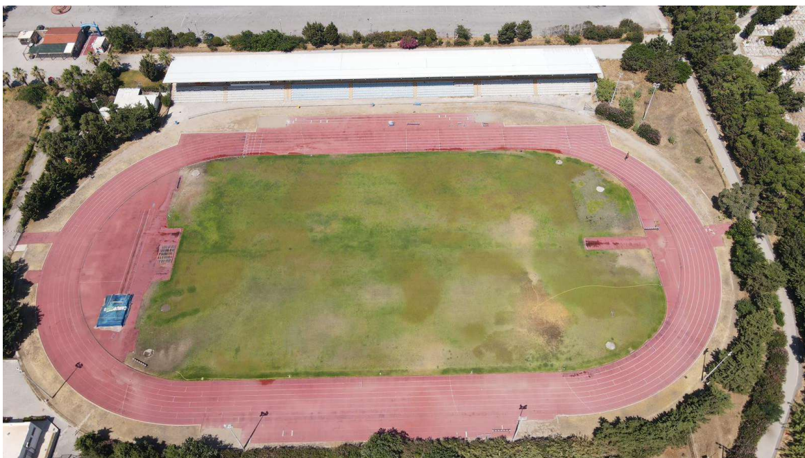
Φωτογραφία 10: Γήπεδο Στίβου & Επιφάνεια Στεγασμένων Κερκίδων Αθλητικού Κέντρου (Από προσωπικό αρχείο του ερευνητή- Λήψη Drone)
