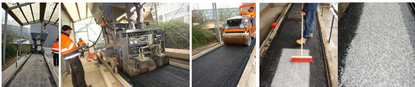
ΕΙΚΟΝΑ 5.14.: Διάστρωση τμήματος δοκιμής με ασφαλτόμιγμα: τμήμα δοκιμής πριν από την ασφαλτόστρωση - διάστρωση ασφαλτομίγματος - συμπύκνωση ασφαλτομίγματος - εφαρμογή υλικών διάστρωσης και απομάκρυνση της περίσσειας αδρανών υλικών - τελική ασφαλτόστρωση - επιφάνεια οδοστρώματος επεξεργασμένη με υλικό διασποράς (πηγή: Wang et al., 2017)
