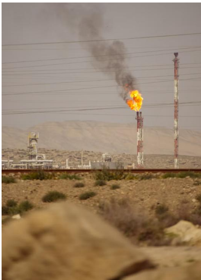
Εικόνα 1: Flare stack σε εγκατάσταση διύλισης πετρελαίου, για την ασφαλή καύση αερίων και την αποτροπή επικίνδυνων καταστάσεων (πηγή https://unsplash.com )
