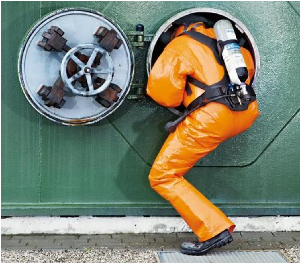
Εικόνα 15: Εργασία σε περιορισμένο χώρο βιομηχανικής εγκατάστασης με χρήση εξοπλισμού ασφαλείας και συστήματος διάσωσης (πηγή https://zul1979.blogspot.com )
