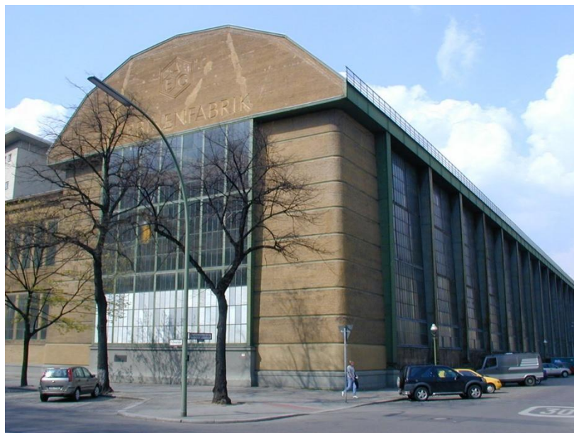
Εικόνα 14. Peter Behrens, AEG Turbine Factory / Εργοστάσιο Τουρμπινών της AEG, Βερολίνο-Moabit, 1908-1910, εξωτερική άποψη.
