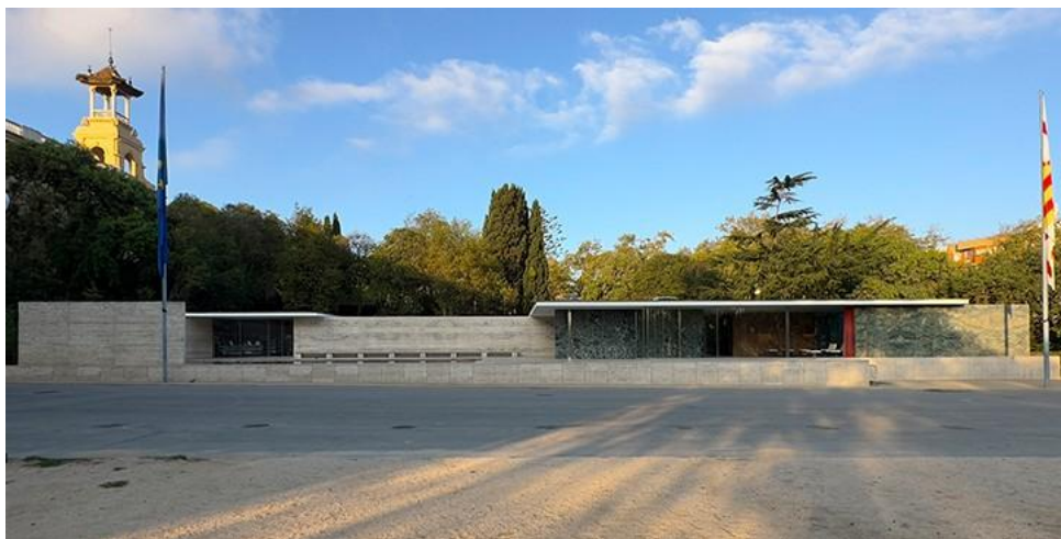
Εικόνα 17. Ludwig Mies van der Rohe και Lilly Reich, Γερμανικό Περίπτερο της Βαρκελώνης, γενική άποψη του ανακατασκευασμένου περιπτέρου, αρχικό έργο 1929, ανακατασκευή 1983-1986.
