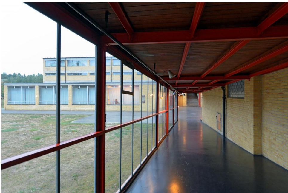
Εικόνα 12. Hannes Meyer και Hans Wittwer, Ομοσπονδιακή Σχολή της ADGB στο Bernau, γυάλινος διάδρομος σύνδεσης των επιμέρους πτερόγων, 1928-1930.
