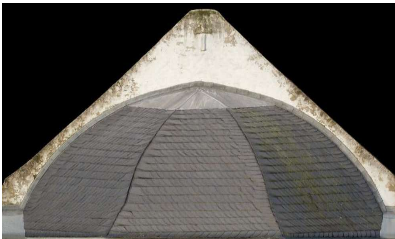
Εικόνα 88. Το ανατολικό αέτωμα με εμφανή τα σημάδια από την υγρασία. (Πηγή: Ιδία επεξεργασία Reality Scan)
