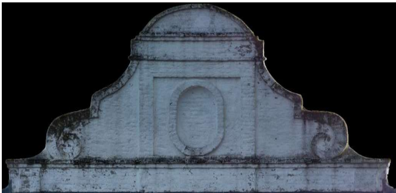
Εικόνα 87. Το αέτωμα της στέγης στην πρόσοψη της εκκλησίας. (Πηγή: Ιδία επεξεργασία Reality Scan)
