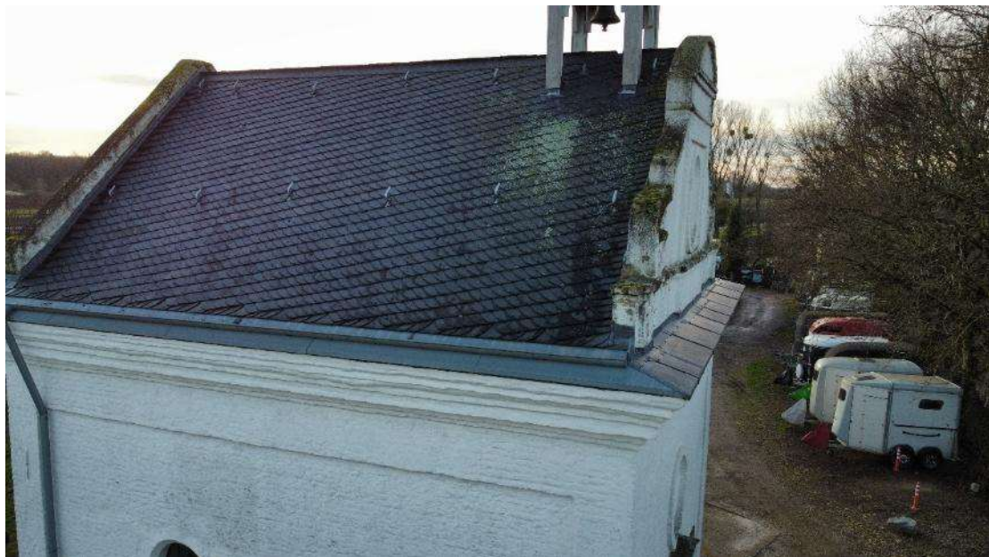
Εικόνα 30. Αποτύπωση της υγρασίας σε σκεπή και τοίχους. (Πηγή: Φωτογραφία συγγραφέα)
