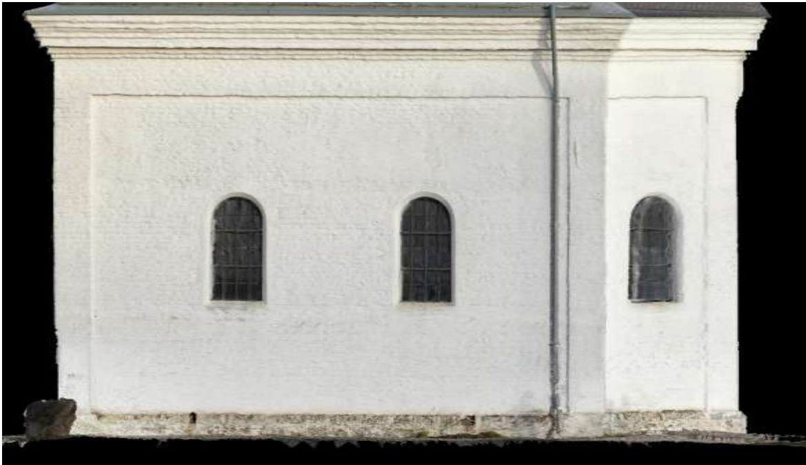
Εικόνα 82. Η νότια πλευρά του ναού. Δεδομένα φωτογραμμετρίας. (Πηγή: Ιδία επεξεργασία Reality Scan)
