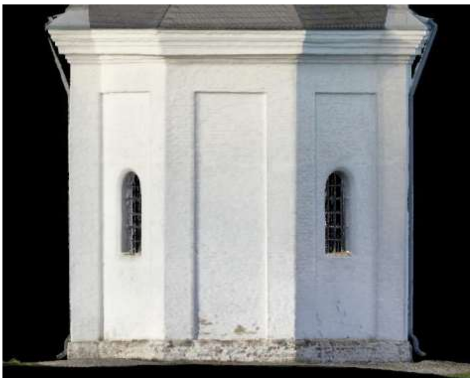
Εικόνα 85. Η δυτική πλευρά του ναού. Δεδομένα φωτογραμμετρίας και σαρωτή χωρίς την χρήση εικόνων του. (Πηγή: Ιδία επεξεργασία Reality Scan)
