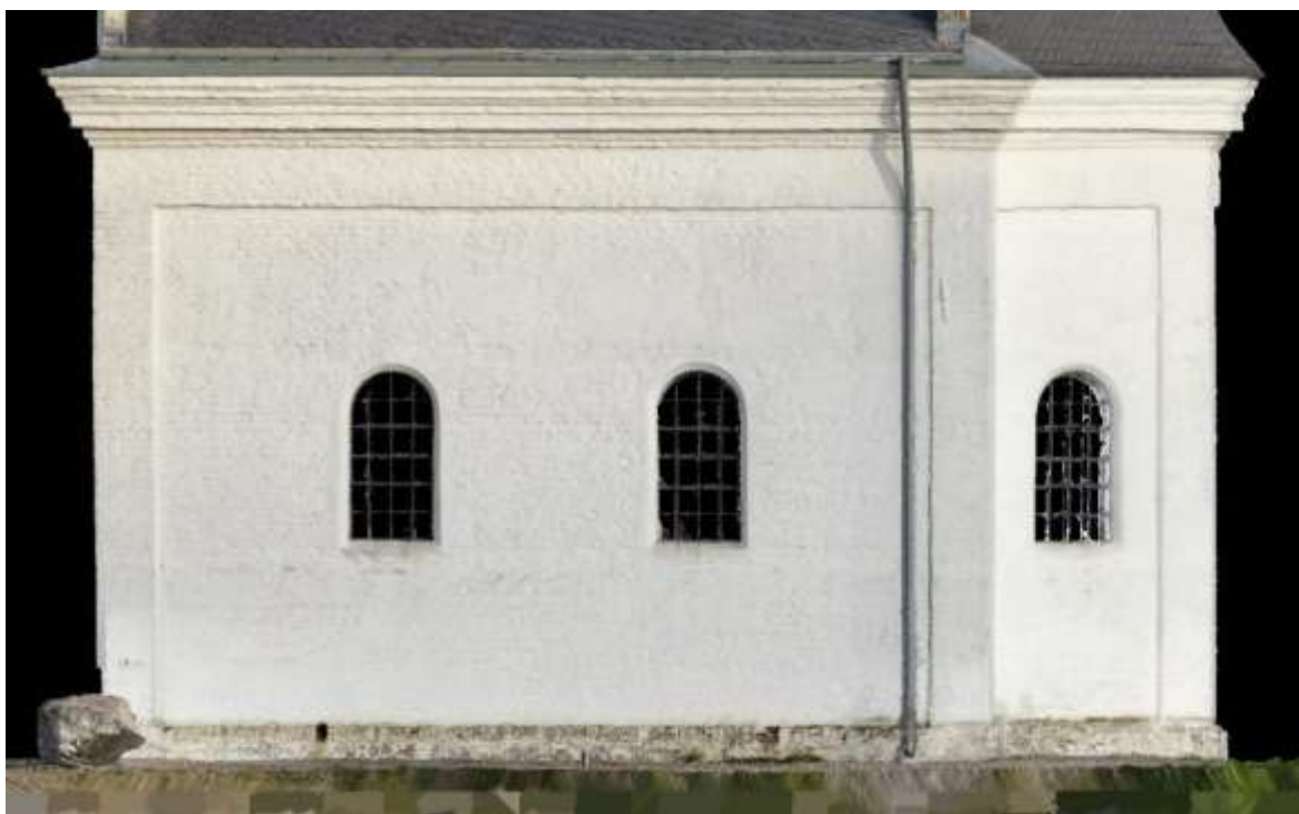
Εικόνα 81. Η νότια πλευρά του ναού. Δεδομένα φωτογραμμετρίας και σαρωτή με την χρήση εικόνων του. (Πηγή: Ιδία επεξεργασία Reality Scan)
