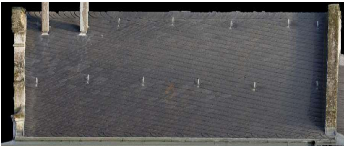
Εικόνα 89. Η νότια πλευρά της σκεπής με τους πλάγιους τοίχους. (Πηγή: Ιδία επεξεργασία Reality Scan)
