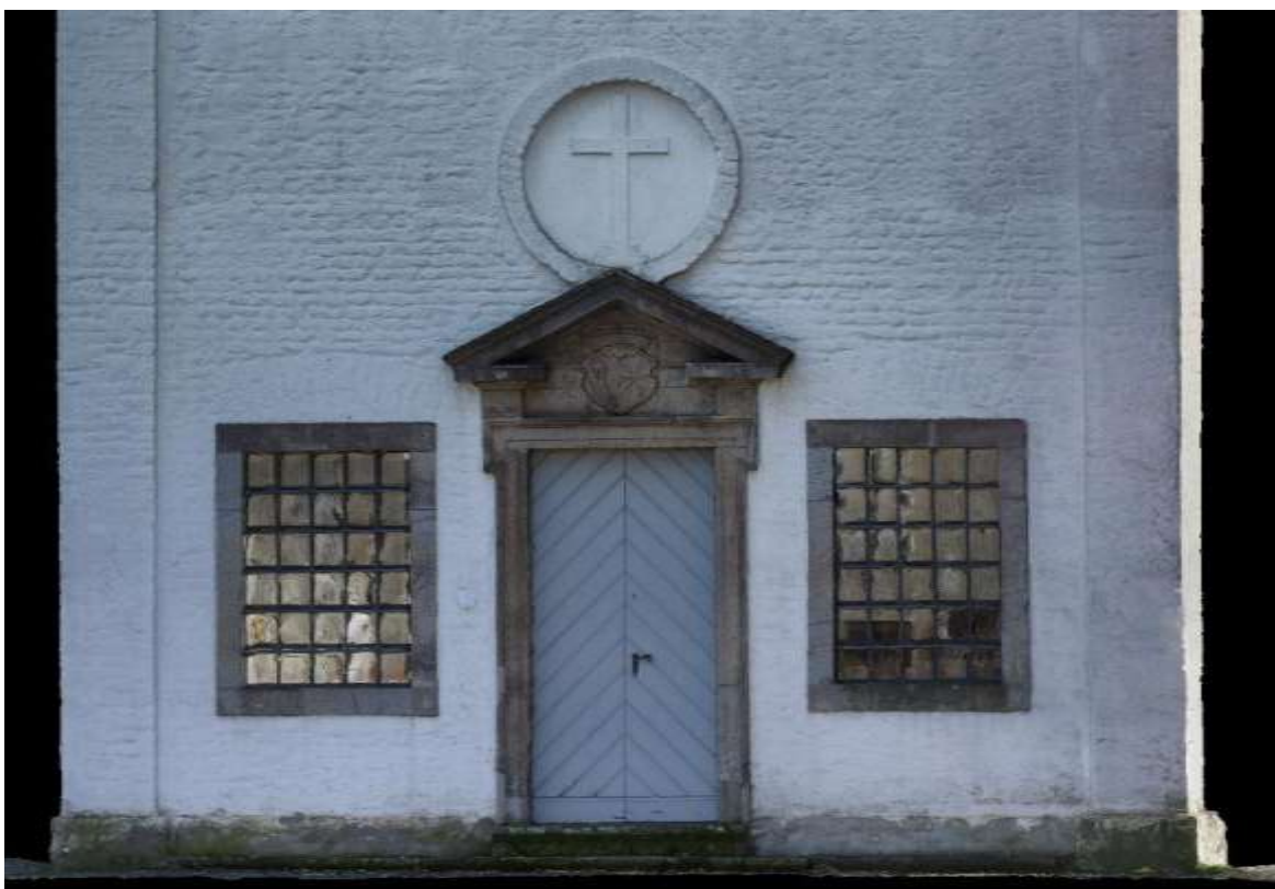
Εικόνα 77. Η πρόσοψη του ναού. Δεδομένα φωτογραμμετρίας. (Πηγή: Ιδία επεξεργασία Reality Scan)
