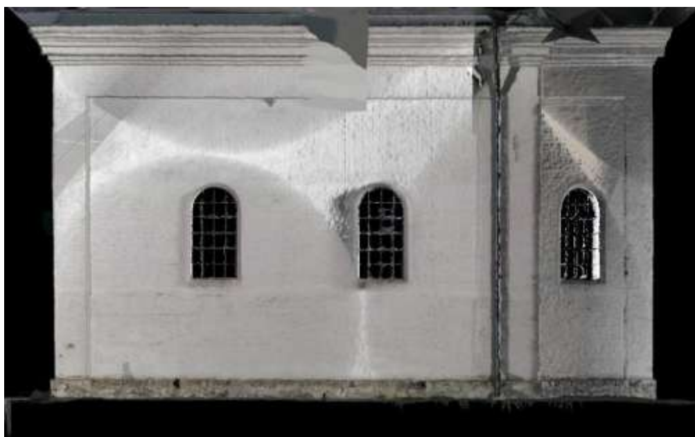
Εικόνα 79. Η νότια πλευρά του ναού. Δεδομένα σαρωτή. (Πηγή: Ιδία επεξεργασία Reality Scan)
