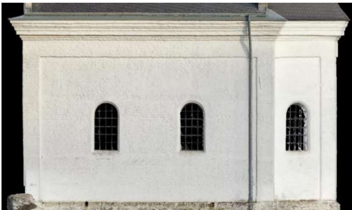
Εικόνα 80. Η νότια πλευρά του ναού. Δεδομένα φωτογραμμετρίας και σαρωτή χωρίς την χρήση εικόνων του. (Πηγή: Ιδία επεξεργασία Reality Scan)
