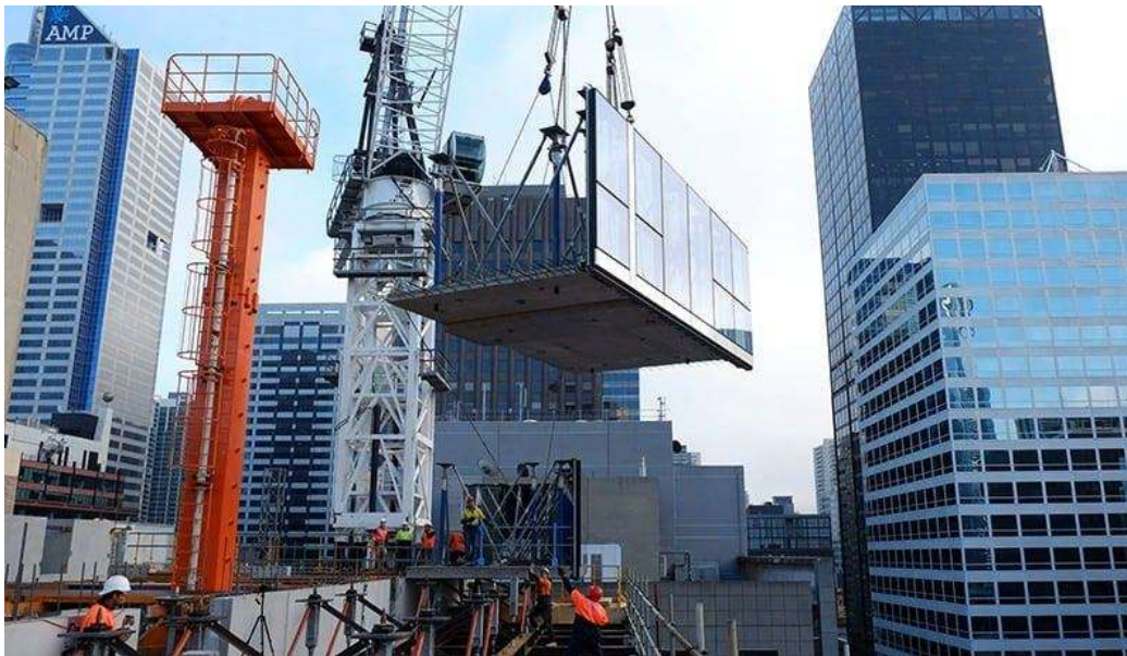
Σχήμα 4.6 Κατασκευή του Collins House στη Μελβούρνη με συναρμολόγηση προκατασκευασμένων τμημάτων από τη Hickory Group (Hickory Group, n.d.)
