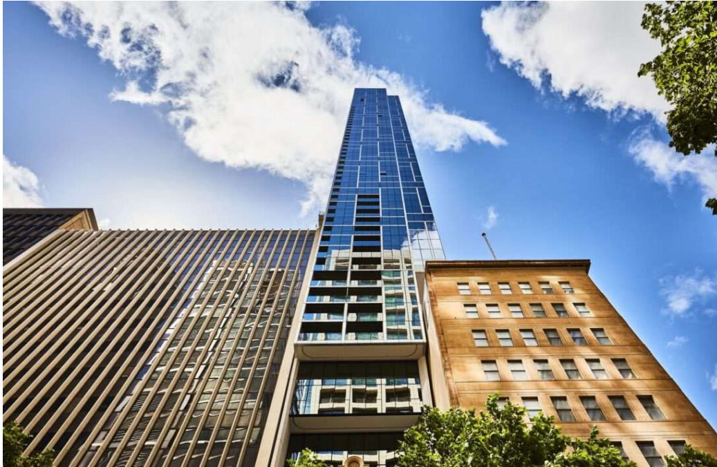
Σχήμα 4.5 Collins House στη Μελβούρνη, έργο υψηλής κατασκευαστικής πολυπλοκότητας σε περιορισμένο αστικό περιβάλλον (Hickory, n.d.)
