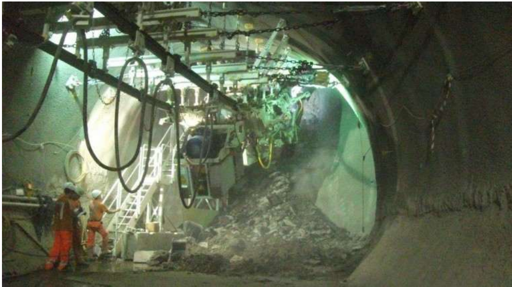
Σχήμα 4.3 Διάνοιξη σήραγγας στη φάση κατασκευής του Crossrail / Elizabeth Line, Λονδίνο (Crossrail Limited, n.d.)
