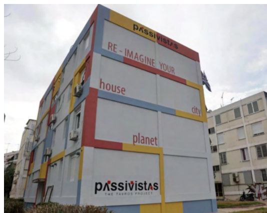
Εικόνα 36:Εξωτερική οπτική κτιρίου μετά την ανακατασκευή, Πηγή: Σκουλούδης (2025)
