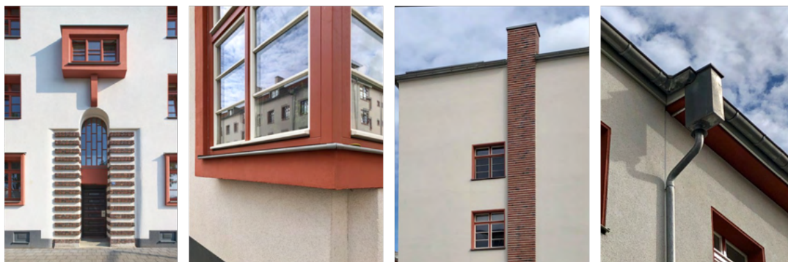
Εικόνα 27: Λεπτομέρειες της εξωτερικής αποκατάστασης των όψεων. Πηγή: Winterhager, 2021
