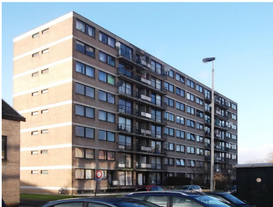
Εικόνα 30: Οψη κτιρίου πριν την ανακατασκευή Πηγή: Divisare, 2022
