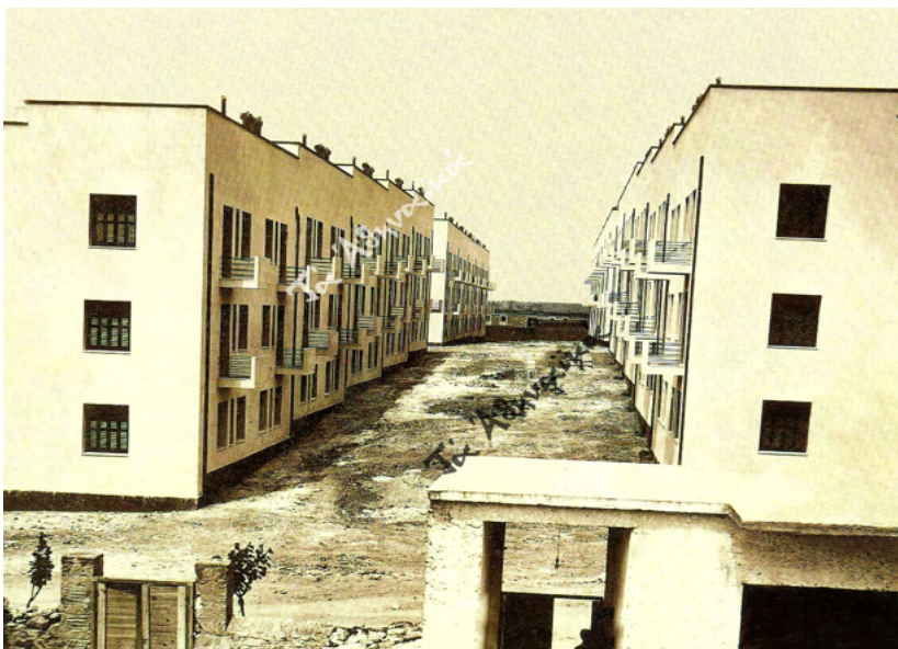
Εικόνα 53: Φωτογραφική λήψη μετά την ολοκλήρωση της ανέγερσης. Πηγή: Σκιαδάς (2019)
