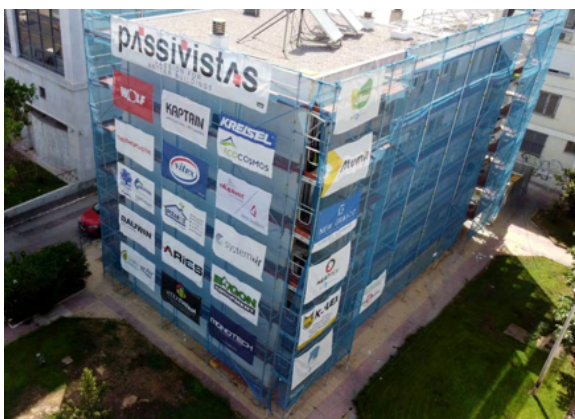
Εικόνα 35:Εξωτερική οπτική κτιρίου κατά την ανακατασκευή, Πηγή:Ecopress (2024)
