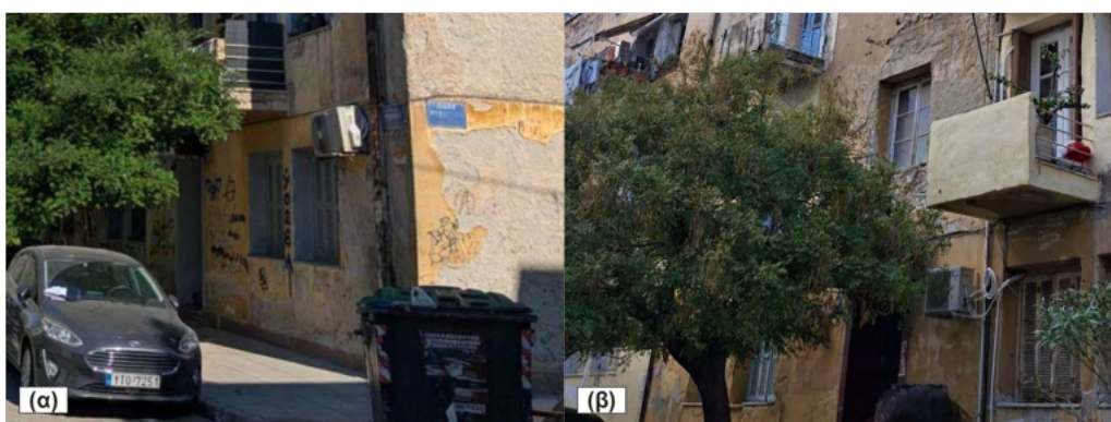
Εικόνα 82:Εξωτερικές μονάδες κλιματιστικών στις όψεις. Πηγή: Προσωπικό αρχείο
