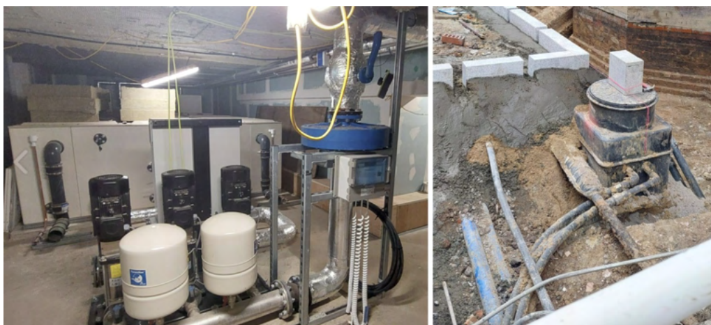
Εικόνα 19: Σύστημα γεωθερμικής αντλίας θερμότητας. Πηγή:Furman, S. (2024), The Sutton Estate Regeneration, Chelsea, RE-DWELL
