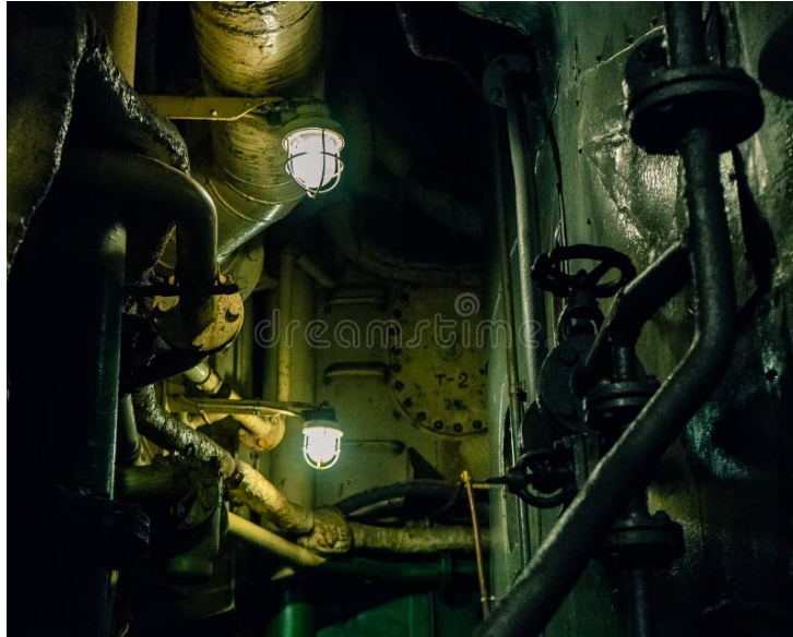
Εικόνα 4.1: Φωτισμός μηχανοστασίου πλοίου με χρήση προβολέων LED
