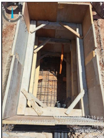
Εικόνα 6-9 Κατασκευή υπόγειου φρεατίου δικτύου FTTH κατά το στάδιο διαμόρφωσης και οπλισμού στο Χιλιομόδι Κορινθίας
