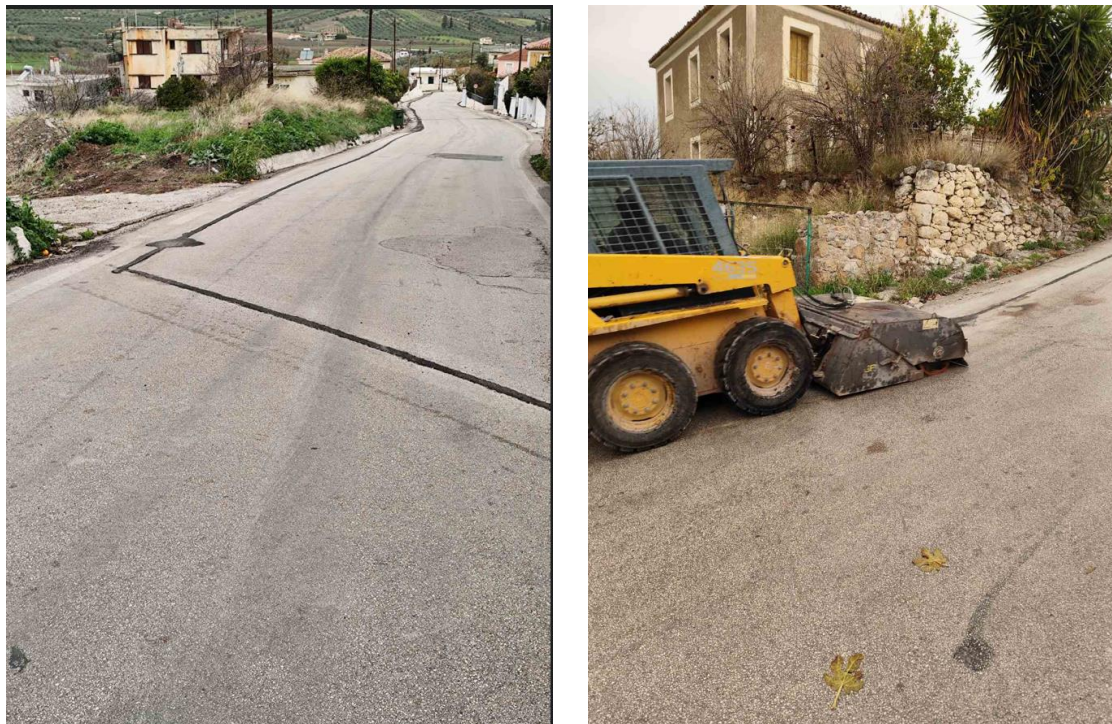
Εικόνα 6-7 Τελική αποκατάσταση της τομής μικροτάφρου μετά την εγκατάσταση υποδομών FTTH στην περιοχή Αγίου Βασιλείου Κορινθίας
