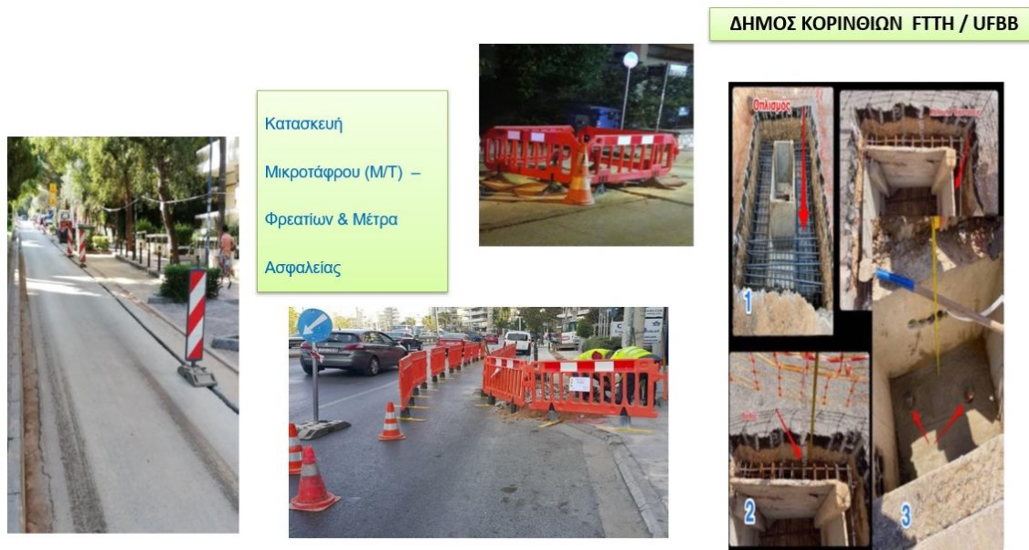
Εικόνα 6-5 Κατασκευή μικροτάφρου (ΜΤ), φρεατίων πρόσβασης και εφαρμογή μέτρων εργοταξιακής ασφάλειας κατά την ανάπτυξη του δικτύου FTTH/UFBB στον Δήμο Κορινθίων.
