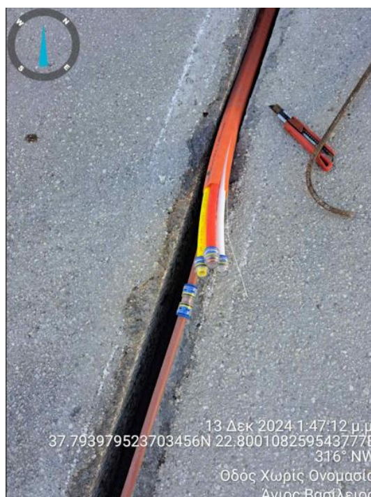
Εικόνα 6-6 Εγκατάσταση μικροσωληνώσεων οπτικών ινών μέσω μεθόδου μικροτάφρου κατά την ανάπτυξη δικτύου FTTH στα Εξαμίλια Κορινθίας
