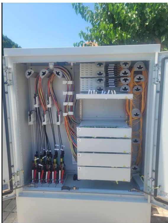
Εικόνα 6-12 Καμπίνες UFBB και εναέρια υποδομή διανομής οπτικών ινών του δικτύου FTTH, με εγκατεστημένο τηλεπικοινωνιακό εξοπλισμό και στοιχεία διασύνδεσης του δικτύου πρόσβασης.
