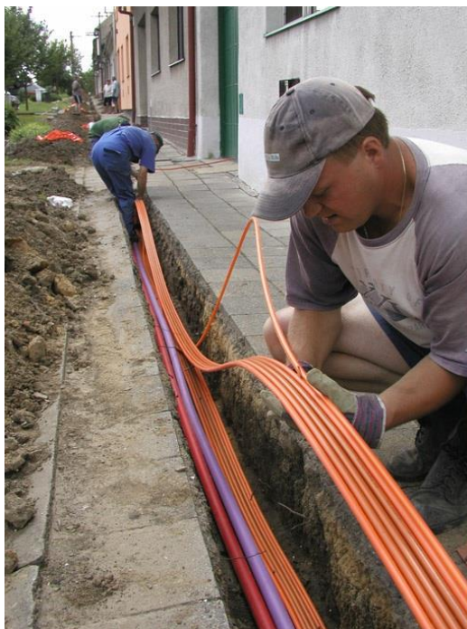
Εικόνα 4-5 Εγκατάσταση υποδομών micro-duct σε υπόγεια όδευση για ανάπτυξη δικτύου FTTH
