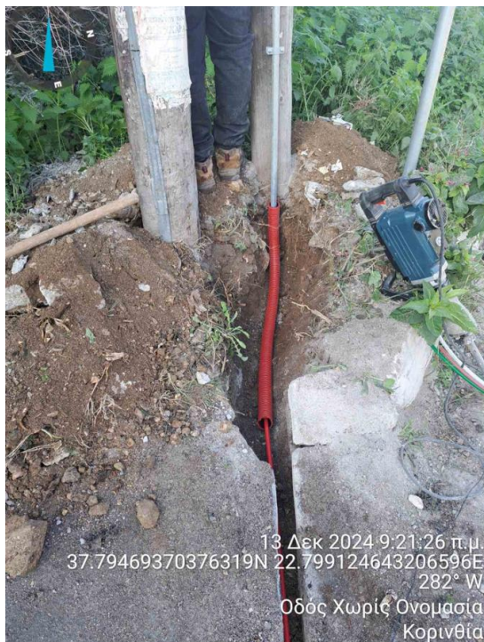
Εικόνα 6-8 Κατασκευή κάθετης όδευσης και τοποθέτηση σωλήνωσης διέλευσης οπτικών ινών στο πλαίσιο του έργου UFBB
