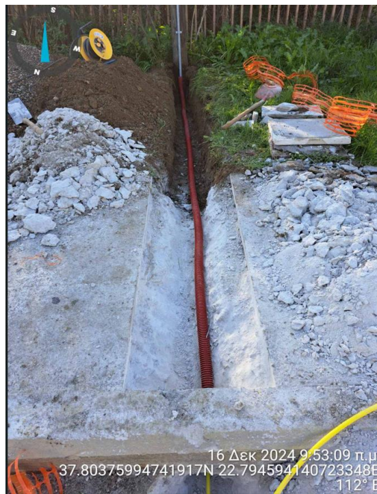
Εικόνα 6-8 Κατασκευή κάθετης όδευσης και τοποθέτηση σωλήνωσης διέλευσης οπτικών ινών στο πλαίσιο του έργου UFBB
