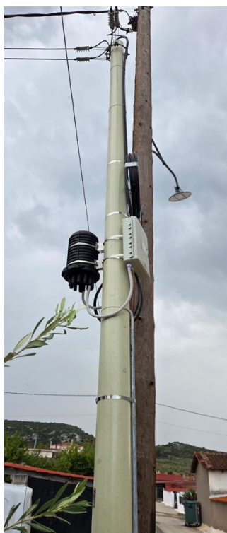
Εικόνα 6-12 Καμπίνες UFBB και εναέρια υποδομή διανομής οπτικών ινών του δικτύου FTTH, με εγκατεστημένο τηλεπικοινωνιακό εξοπλισμό και στοιχεία διασύνδεσης του δικτύου πρόσβασης.
