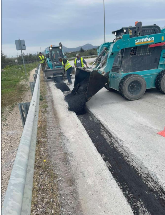
Εικόνα 6-10 Εργασίες ειδικής ασφαλτικής αποκατάστασης και συμπίεσης οδοστρώματος στην Ολυμπία Οδό μετά την ολοκλήρωση των εργασιών εγκατάστασης υποδομών οπτικών ινών του έργου UFBB.
