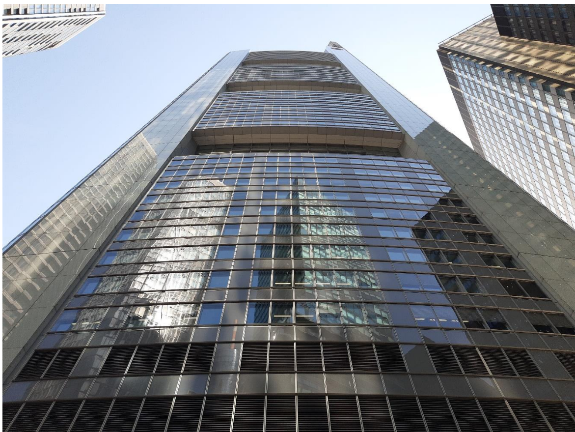
Εικόνα 1- 14: Εξωτερική άποψη του Commerzbank Tower στη Φρανκφούρτη, σχεδιασμένου από το Foster + Partners και ολοκληρωμένου το 1997.
