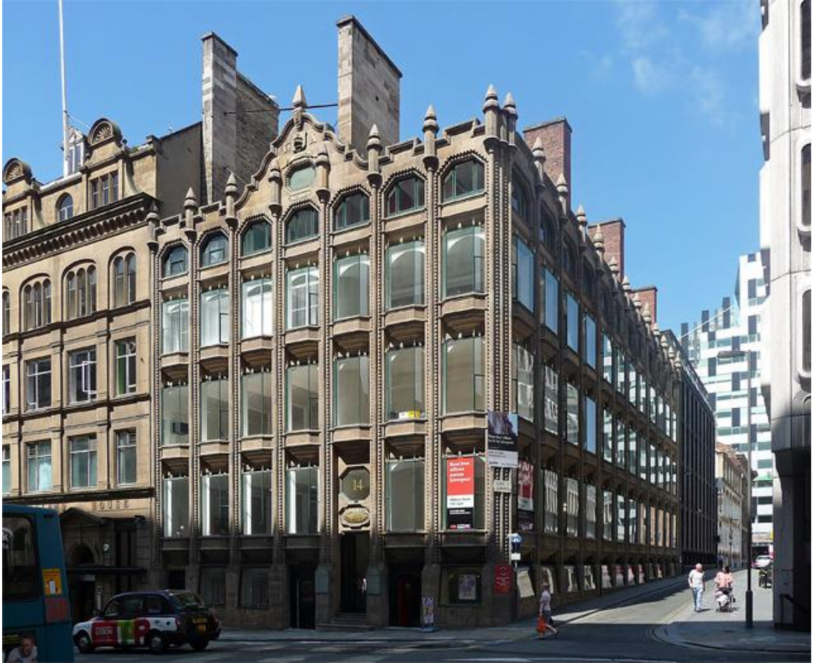
Εικόνα 1 - 8: Oriel Chambers στο Λίβερπουλ (1864), του Peter Ellis, πρώιμο παράδειγμα γραφειακού κτιρίου με εκτεταμένη χρήση υαλοστασίων και χυτοσιδηρού σκελετού. Πηγή: Richards, S. (2011), Geograph, CC BY-SA 2.0.
