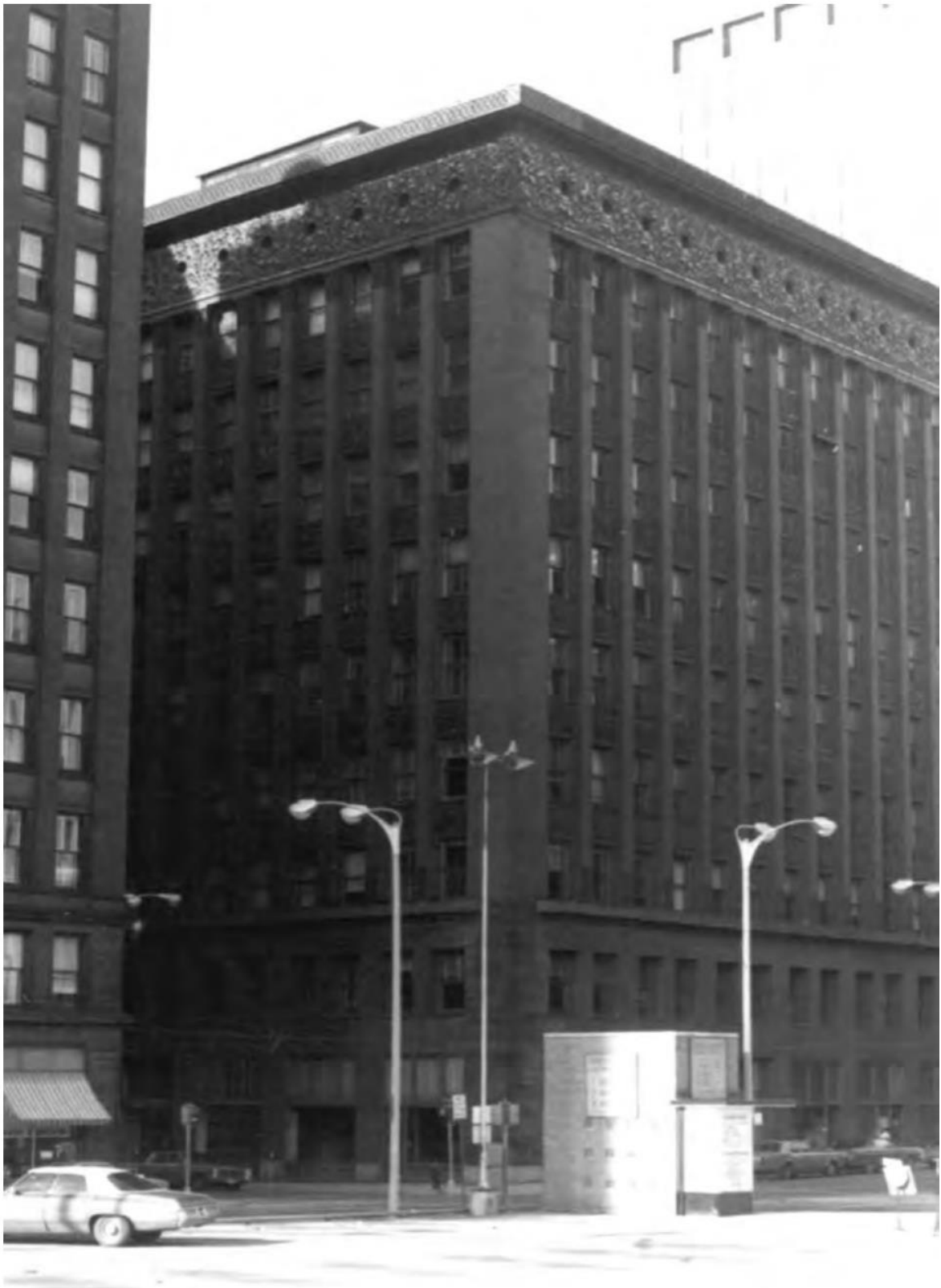
Εικόνα 1-19: Εξωτερική άποψη του Wainwright Building (1891) του Louis Sullivan.
