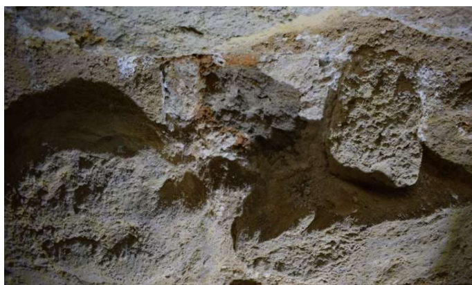
Εικόνα 13 Αποδιοργανωμένο τσιμεντοκονίαμα με εμφανή συγκέντρωση αδιάλυτων αλάτων από τοιχοποιία του Μεγάρου του Βασιλέως (προσωπικό αρχείο Ζάχου Μ.)
