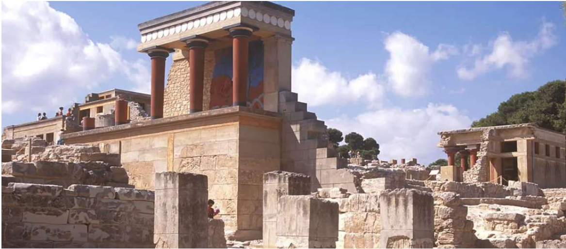
Εικόνα 9 Χαρακτηριστική εικόνα της Βόρειας Εισόδου του Ανακτόρου με εκτεταμένη χρήση οπλισμένου σκυροδέματος από της αναστηλώσεις του Α. Evans ( Knossos documenta.gr).
