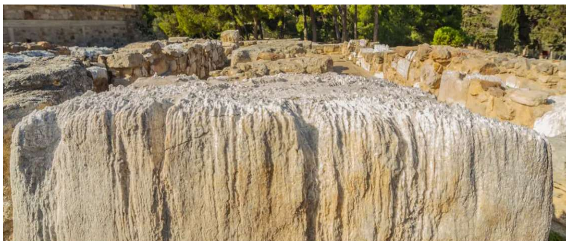
Εικόνα 6 Χαρακτηριστική εικόνα γυψόλιθου που έχει υποστεί αποσάθρωση. Πλευρική διάβρωση (αυλάκια και κοιλότητες) ( www.knossosdocumenta.gr )
