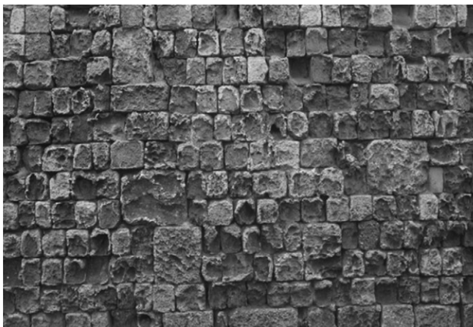
Εικόνα 4 Φαινόμενα φθοράς λίθου λόγω μηχανισμού αλατονέφωσης (Stefanis, et.al, 2009).
