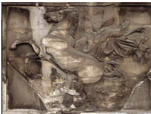
Εικόνα 1 Φθορές λόγω ατμοσφαιρικής ρύπανσης ( www.visma.gr ).
