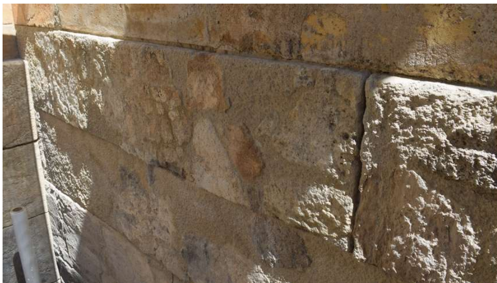
Εικόνα 19 Μέγαρο Βασιλέως: Αποκατάσταση λιθοδομής με την εφαρμογή συμβατών υλικών (προσωπικό αρχείο Ζάχου Μ)
