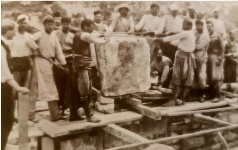
Εικόνα 8 Αναστηλωτικές εργασίες στο Μέγαλο Κλιμακοστάσιο ( Αρχείο Μουσείου Ashmolean)
