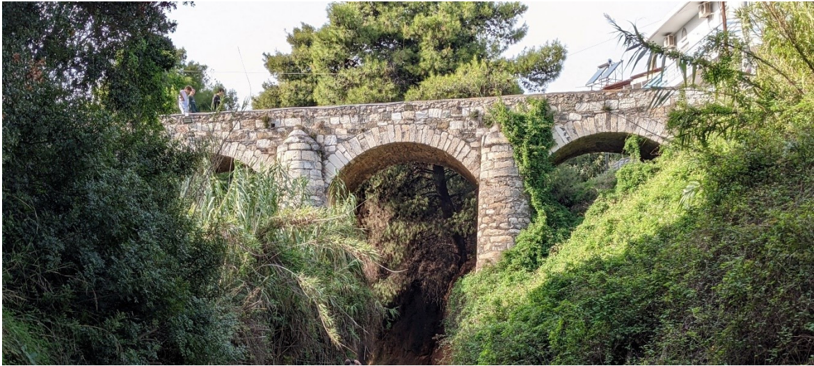
Κτίριο 13 Πεντάτοξη γέφυρα των Μελισσίων
