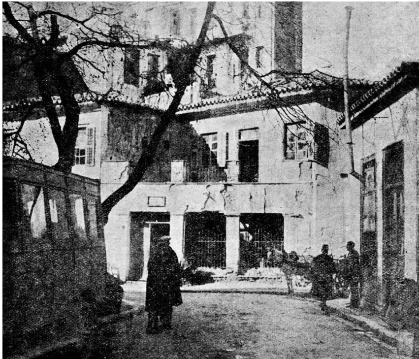
Κτίριο 6 Ξενοδοχείο Ευρώπη (Αθήνα)
