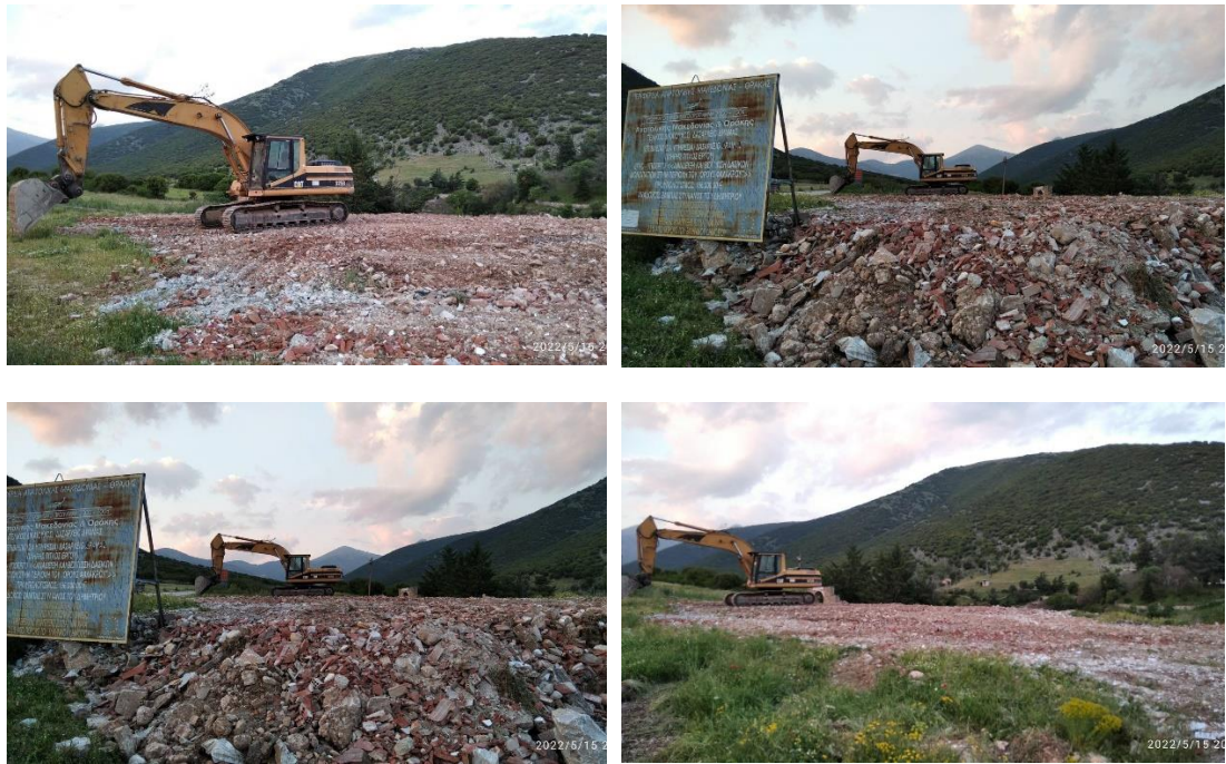
Εικόνα 4 Αξιοποίηση των ΑΕΚΚ για τη δημιουργία χώρου στάθμευσης στο φαράγγι της Πετρούσας του Δήμου Προσοτσάνης – φωτό Γιάγκου Σ.
