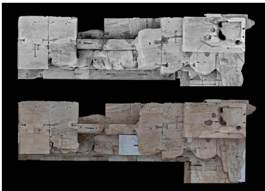
Εικ. 26. Ορθομωσαϊκά της κάτοψης της ΒΔ γωνίας του Παρθενώνα, πριν και μετά την αποκατάσταση.
