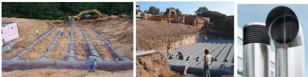
Εικόνα 68: Εργασίες εγκατάστασης εναλλακτών θερμότητας. (δεξιά) στοιχεία απορρόφησης και απελευθέρωσης αέρα. (Πηγή: Αποστολίδου Γ.: «Συστήματα αξιοποίησης του εδάφους για θέρμανση-ψύξη κτηρίων», Διπλωματική Εργασία, Αριστοτέλειο Πανεπιστήμιο Θεσσαλονίκης, 2010) (REHAU Unlimited Polymer Solutions: http://www.rehau.com/gb-en/ ).
