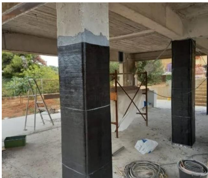
Εικόνα 2.2: Ενίσχυση με Ανθρακοϋφασμα
