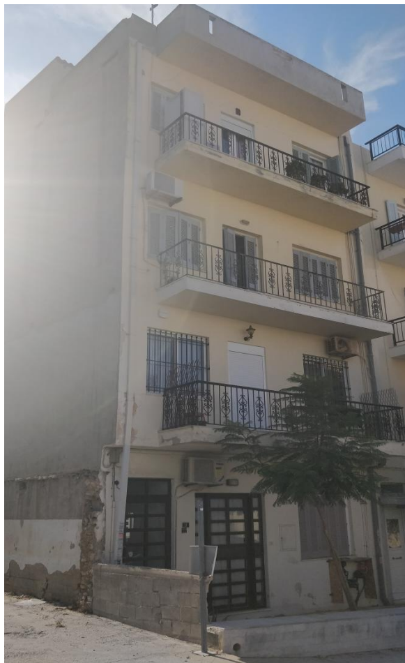
Εικόνα 3.1: Όψη του προς μελέτη κτιρίου
