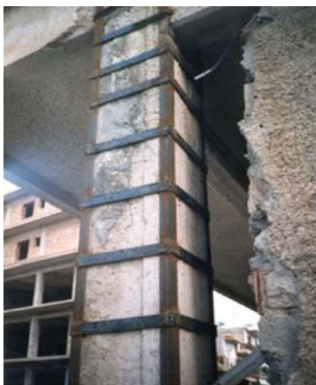
Εικόνα 2.3: Ενίσχυση με Χαλύβδινα Ελάσματα
