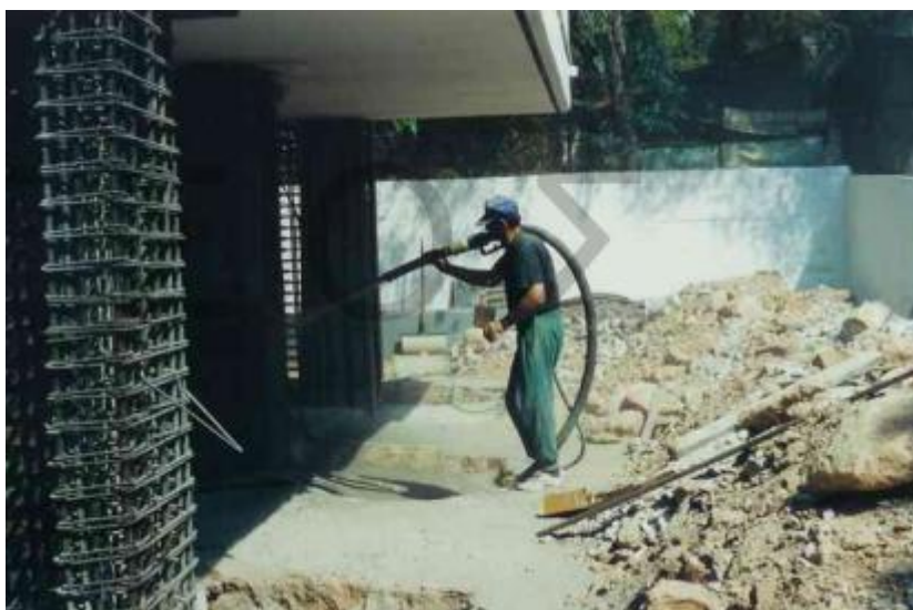
Εικόνα 2.1: Ενίσχυση με μανδύες Οπλισμένου Σκυροδέματος
