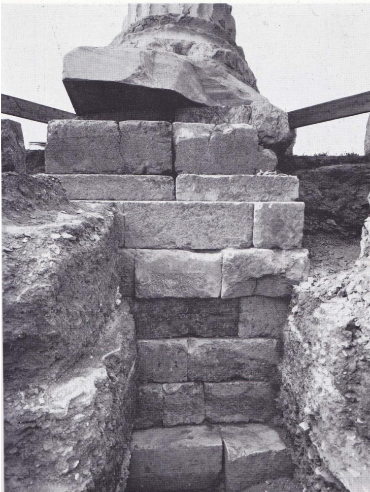
Εικ.5. Η Θεμελίωση του κίονα της ΝΔ πλευράς του Ναού που κατέρρευσε από τη καταιγίδα του 1852 . Διακρίνονται 7 στρώσεις λίθων κάτω από το στυλοβάτη. Πηγή: Pictorial dictionary of Ancient Athens-John Traulso/New York 1980
