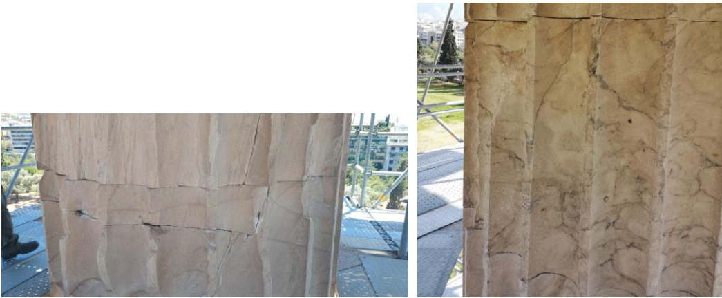
Εικ.13. Ατέλειες του υλικού που εξελίχθηκαν σε ρωγμές
