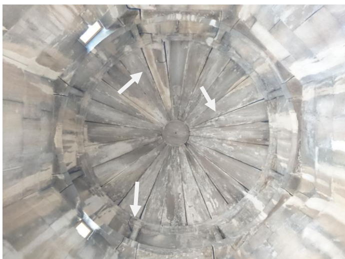
Εικ.18. Άνοψη της στέγης του μνημείου με τις θέσεις των ρωγμομέτρων και κλισιομέτρων
