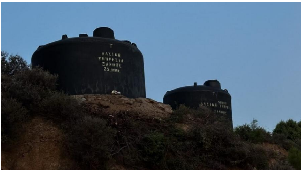
Εικόνα 1-4 Εικόνα απο Υδατοδεξαμενές κλειστού τύπου (25.000 λίτρων)
