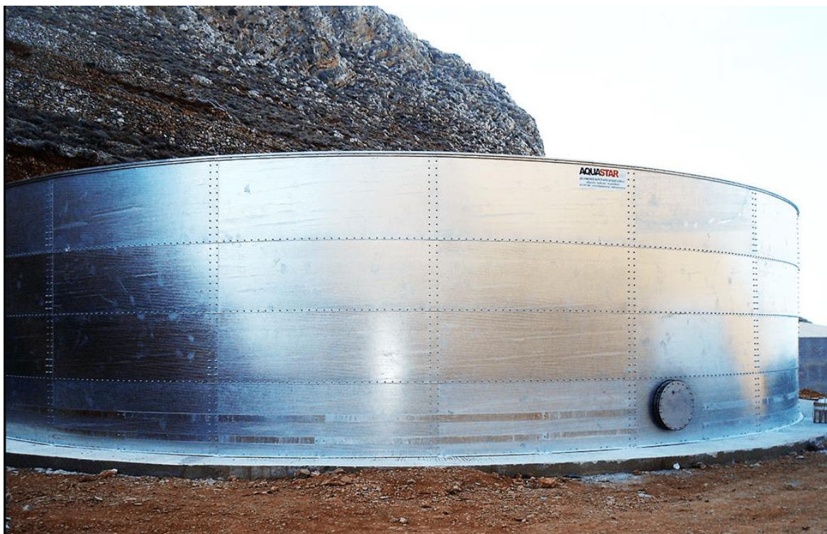
Εικόνα 1-6 Εικόνα απο Υδατοδεξαμενή μεταλλική ανοιχτού τύπου (1.000.000 λίτρων)
