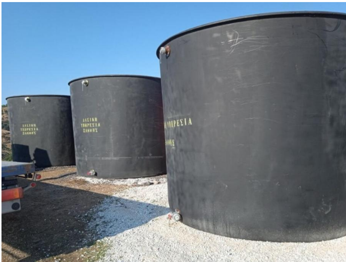
Εικόνα 1-3 Εικόνα από Υδατοδεξαμενές ανοιχτού τύπου (37.000 λίτρων)
