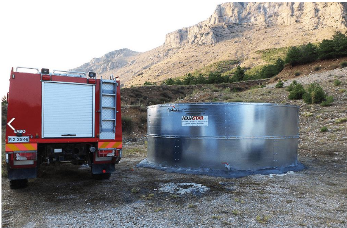
Εικόνα 1-5 Εικόνα απο Υδατοδεξαμενή μεταλλική ανοιχτού τύπου (40.000 λίτρων)
