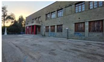
Εικόνα 2: Η νότια όψη του Παπαστρατέιου Σχολείου. (Πηγή: Προσωπικό αρχείο)
