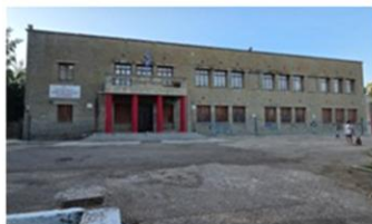
Εικόνα 1: Η νότια όψη του Παπαστρατέιου Σχολείου. (Πηγή: Προσωπικό αρχείο)
