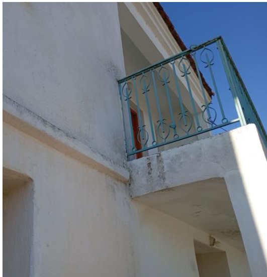
Διόγκωση, αποφλοίωση και ρηγμάτωση επιχρίσματος στη βάση φέρουσας λιθοδομής
