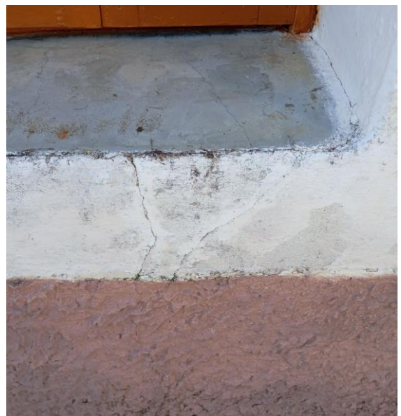
Οριζόντια τριχοειδής ρηγμάτωση στη βάση (ποδιά) εξωτερικής τοιχοποιίας
