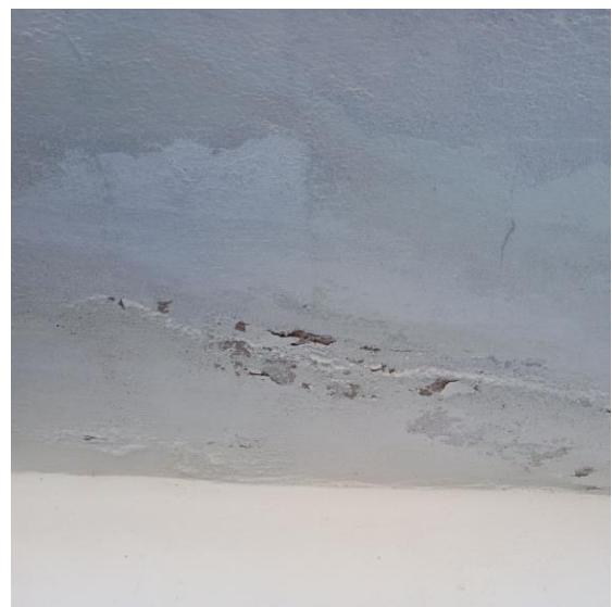
Διόγκωση, αποφλοίωση και ρηγμάτωση επιχρίσματος στη βάση φέρουσας λιθοδομής
