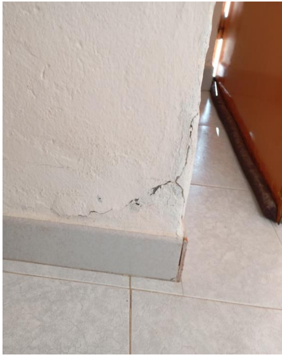
Ρηγμάτωση και αποκόλληση επιχρίσματος σε ακμή φέρουσας λιθοδομής
