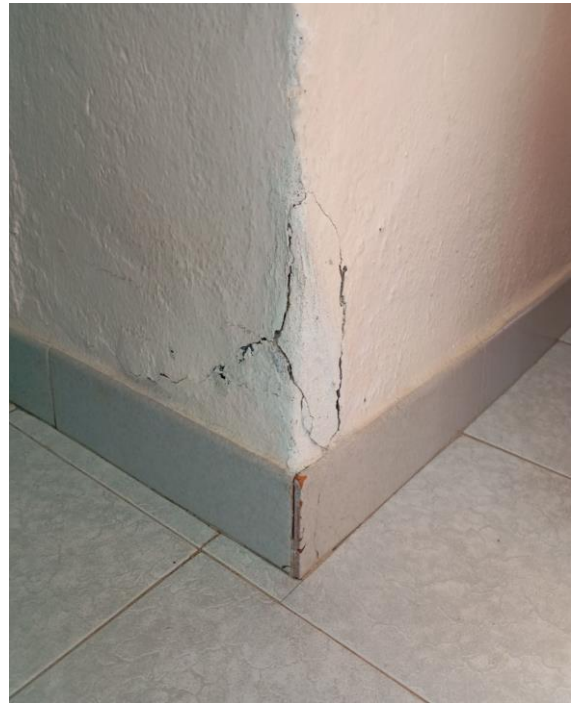
Ρηγμάτωση και αποκόλληση επιχρίσματος σε ακμή φέρουσας λιθοδομής
