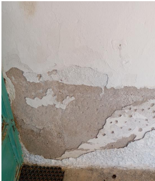
Ρηγμάτωση και αποκόλληση επιχρίσματος σε ακμή φέρουσας λιθοδομής
