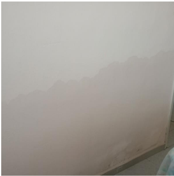
Εμφανές μέτωπο ανιούσας υγρασίας σε εσωτερικό επίχρισμα λιθοδομής. Υγροθερμική αστοχία λόγω θερμογεφυρών και ανάπτυξη διάχυτων κηλίδων υγρασίας
