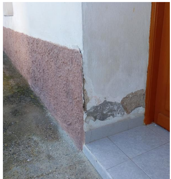
Ρηγμάτωση και αποκόλληση επιχρίσματος σε ακμή φέρουσας λιθοδομής
