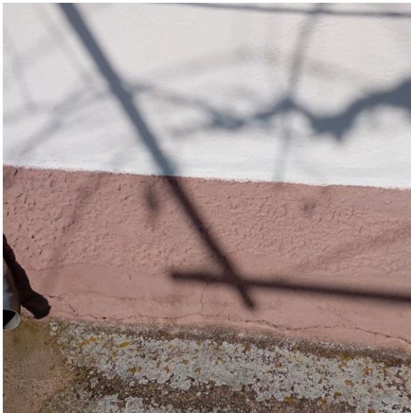
Οριζόντια τριχοειδής ρηγμάτωση στη βάση (ποδιά) εξωτερικής τοιχοποιίας
