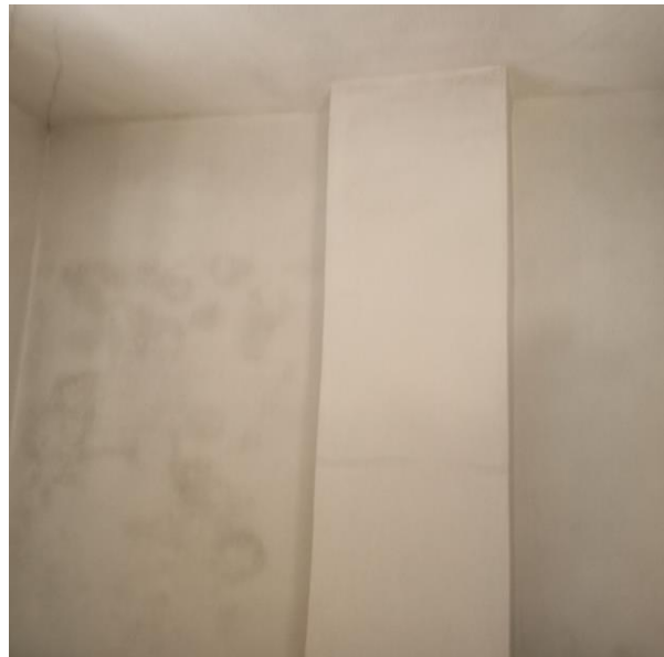
Εμφανές μέτωπο ανιούσας υγρασίας σε εσωτερικό επίχρισμα λιθοδομής. Υγροθερμική αστοχία λόγω θερμογεφυρών και ανάπτυξη διάχυτων κηλίδων υγρασίας
