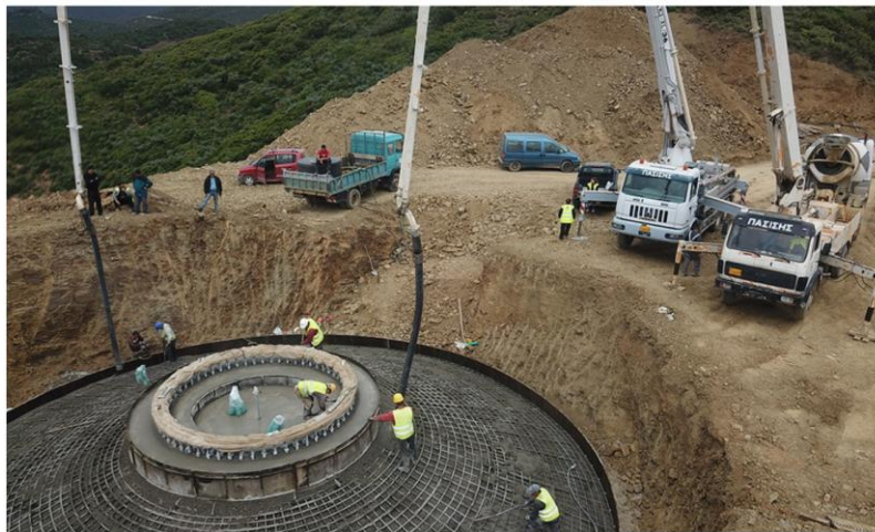
Εικόνα 6.7: Δημιουργία πυλώνα και τοποθέτηση οπλισμένου σκυροδέματος
