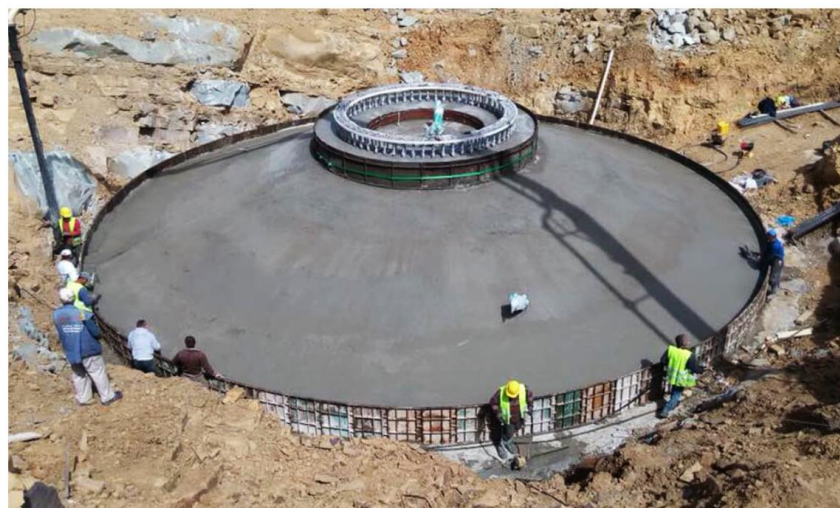
Εικόνα 6.8: Ολοκλήρωση σκυροδέματος και δημιουργία πυλώνα ανεμογεννήτριας
