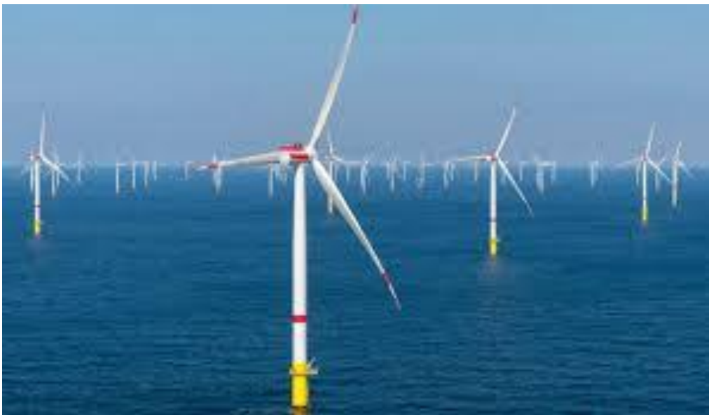
Εικόνα 2.1: Παράδειγμα ανεμογεννητριών γνωστών ως «Δανική Ιδέα» (Danish Concept).
