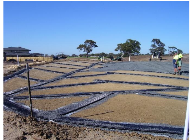
Εικόνα 14. Κατασκευή συστήματος αποστράγγισης του green.
