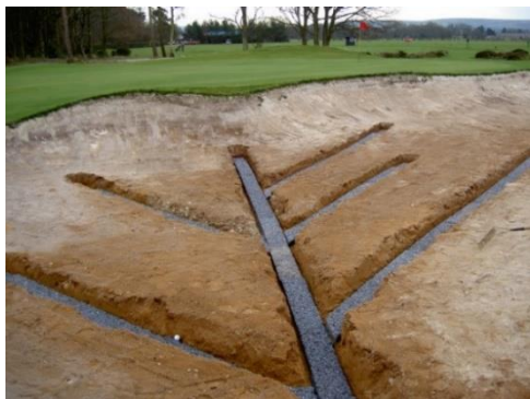
Εικόνα 12. Το σύστημα αποστράγγισης των bunkers σε σχήμα ψαροκόκκαλου.
