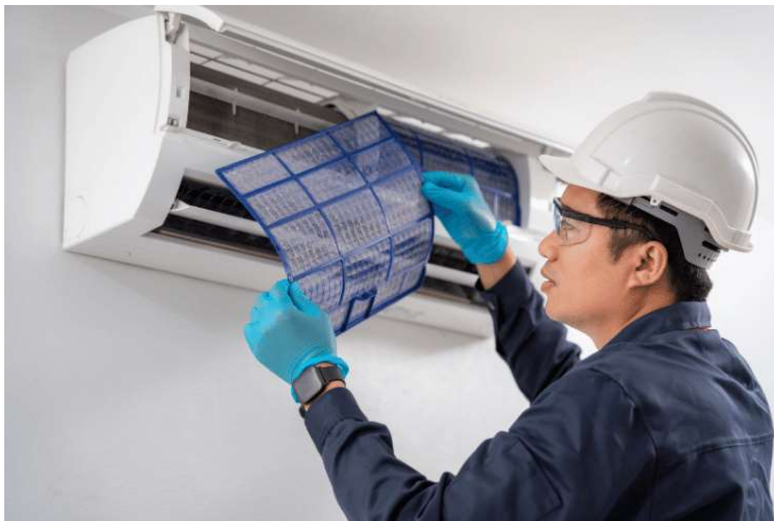
Εικόνα 2:Εργασίες συντήρησης εσωτερικής κλιματιστικής μονάδας
