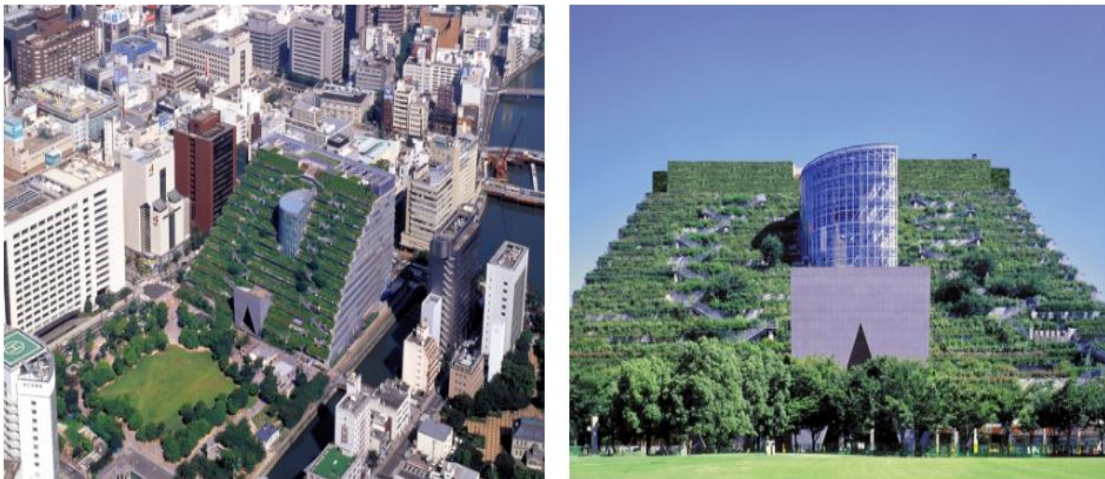
Εικόνα 18: Κτίριο FukuokaPrefecturalInternationalHall-Παράδειγμα παθητικού δροσισμού.
