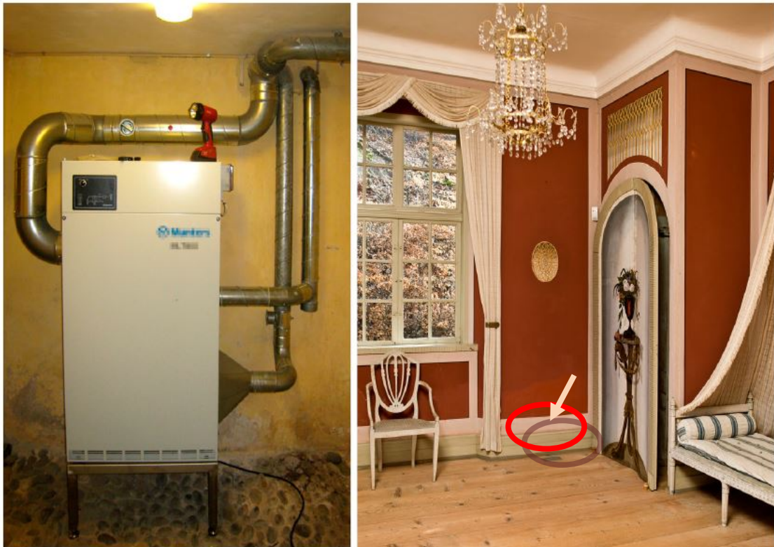
Εικόνα 30: Αφυγραντήρας με απορρόφηση (αριστερά) και χώρος που δέχεται το ζεστό αέρα μέσω αγωγών από τη μικρή σχάρα(κύκλος) στο πάτωμα.
