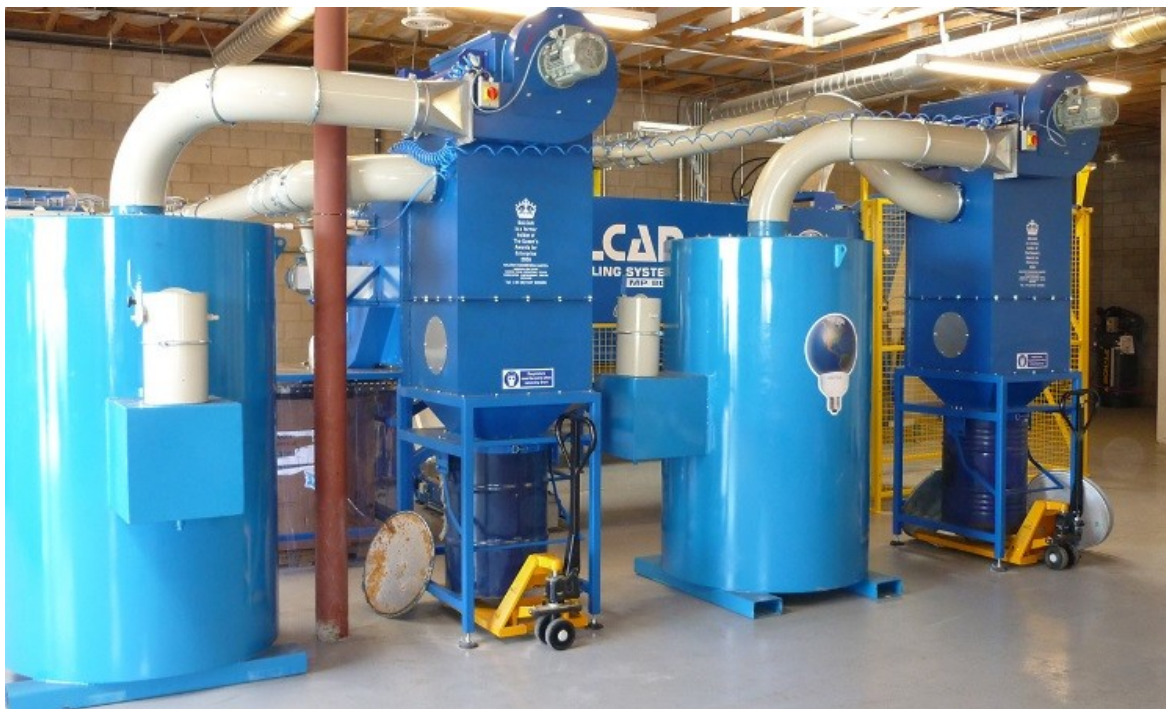
Εικόνα 22: Σύστημα φιλτραρίσματος εκπομπών υδραργύρου (ΟΙΚΟΚΥΚΛΙΟΣ Α.Ε., 2024)
