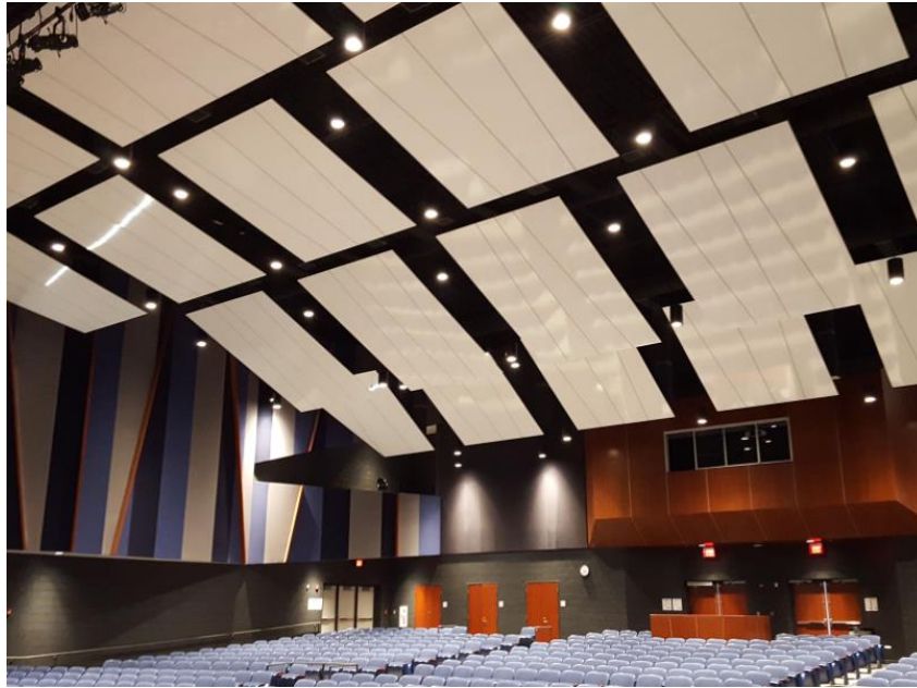
Σχήμα 3.9 : Πρακτική εφαρμογή ακουστικής ψευδοροφής από ανακλαστήρες (kineticsnoise.com, https://kineticsnoise.com/spaces/auditoriums-performing-arts/reflection )
