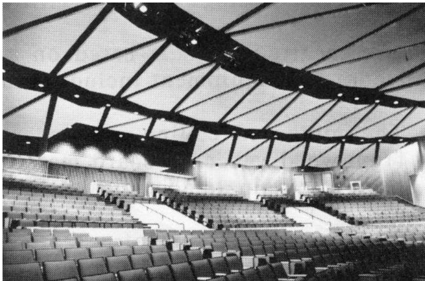
Σχήμα 3.10 : Κεντρικό αμφιθέατρο Triplex Center, Νέα Υόρκη, επενδυμένο με ακουστική ψευδοροφή από ανακλαστήρες 1984 (Σωτηροπούλου,2015)
