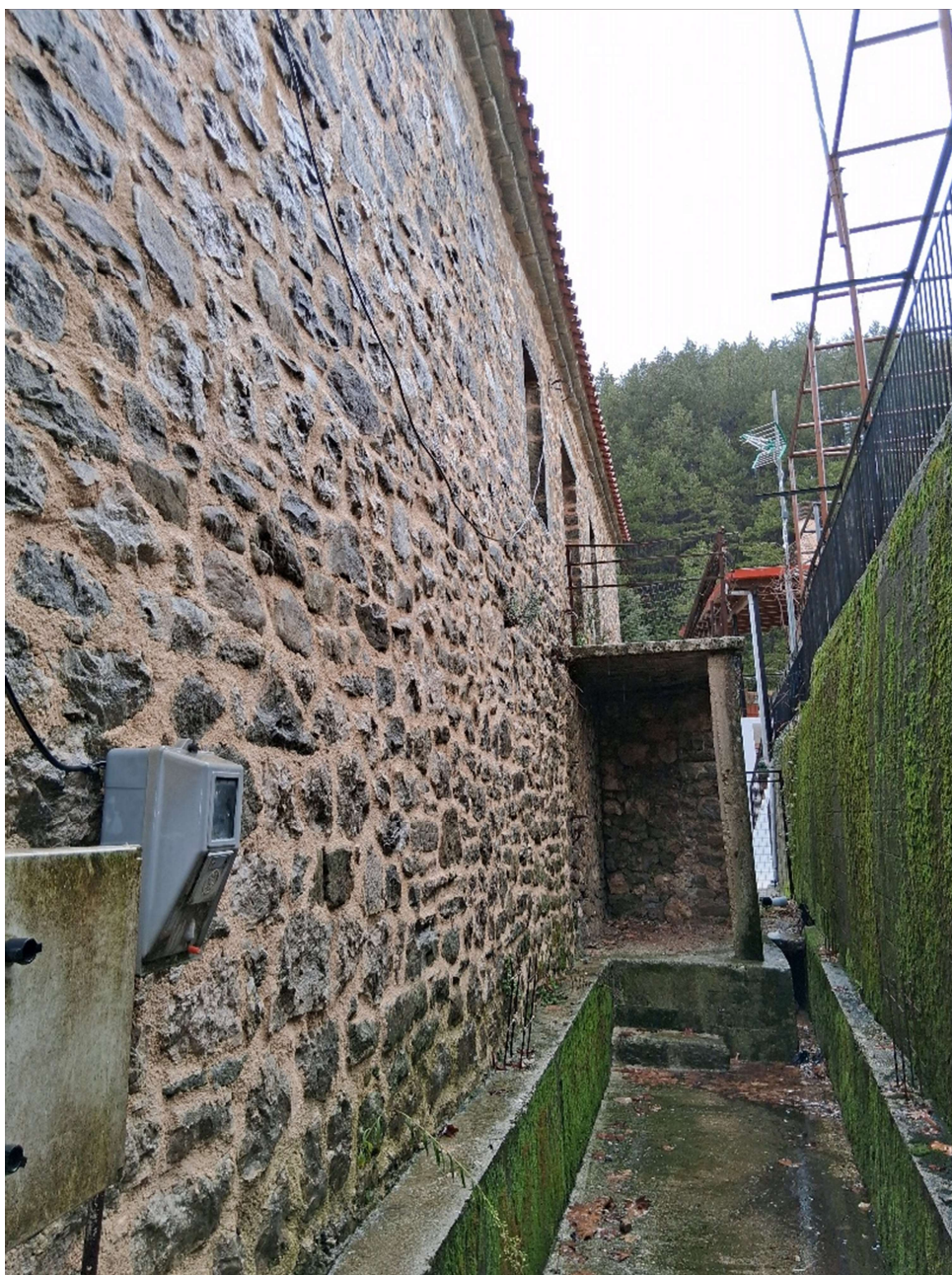
ΑΝΑΤΟΛΙΚΗ ΟΨΗ – ΛΗΨΗ ΝΟΤΙΟ ΑΝΑΤΟΛΙΚΗ
