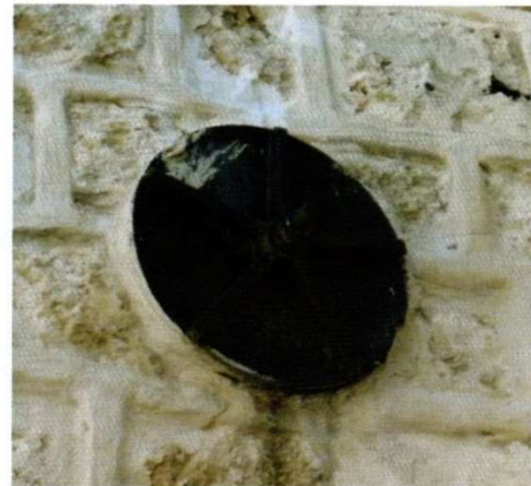
Κυκλική πλάκα αγκύρωσης με νευρώσεις.
