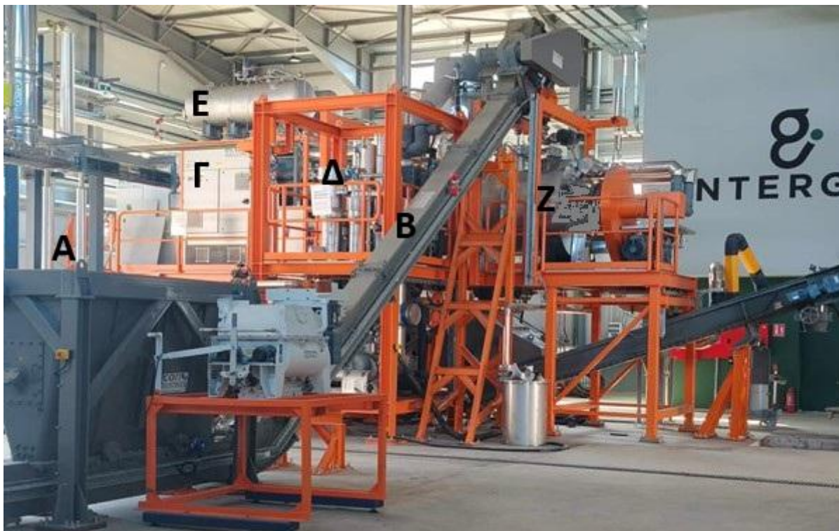
Εικόνα 9. Εγκατάσταση θερμικής εκρόφησης στην μονάδα της INTERGEO στην Θεσσαλονίκη.
