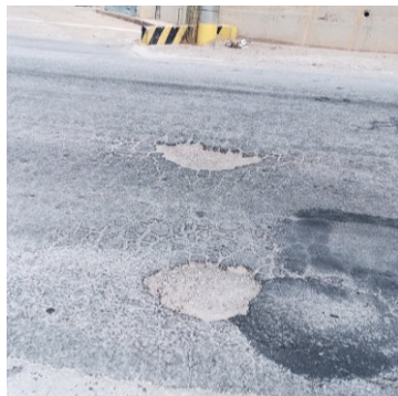
Σχήμα 1. Μορφές φθοράς (λακκούβες) σε Ελληνικό οδόστρωμα.
