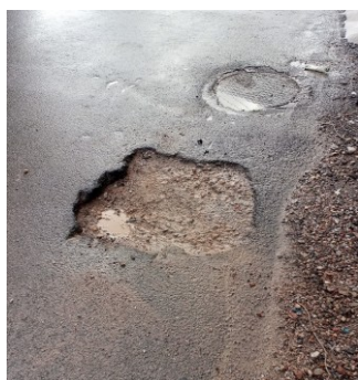
Σχήμα 3. Παράδειγμα λακκούβας.
