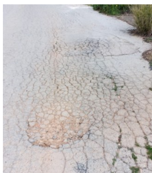
Σχήμα 2. Παράδειγμα αλιγατορικής ρωγμής.
